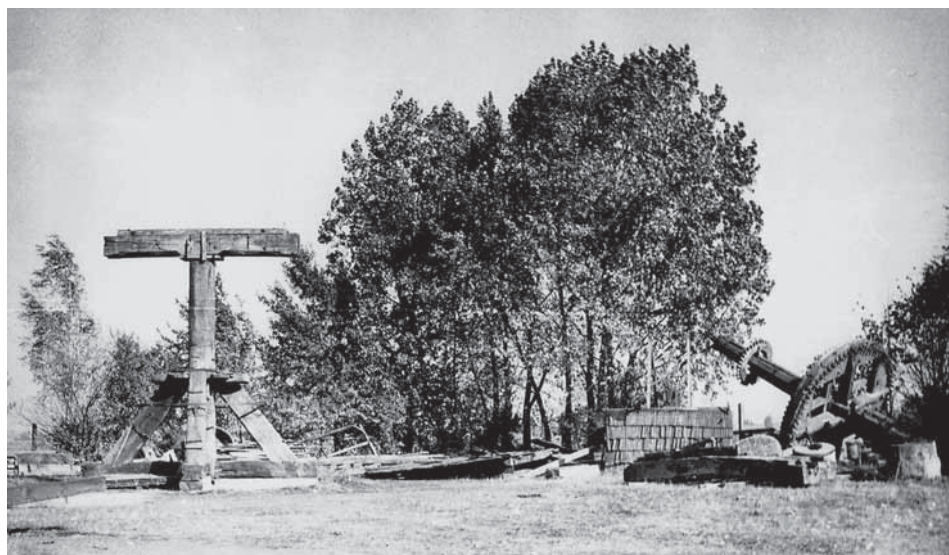
RYC. 7. Gruntowny remont wiatraka na tzw. małym skansenie Muzeum Pierwszych Piastów na Lednicy w 1979 roku; fot. archiwum MPPL
