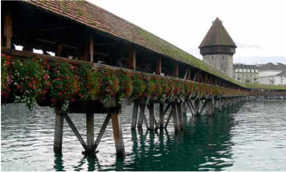
Ryc. 23. Lucerna. Widok ogólny na Kapelbrücke. Fot. G. Wilke FIG. 23. Lucerne. A general view of Kapelbrücke. Photo by G. Wilke
