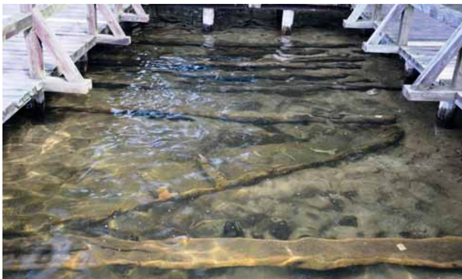
Ryc. 20. Ostrów Lednicki. Pomost widokowy w miejscu wyspowego przyczółka mostu tzw. „poznańskiego” z widocznymi elementami konstrukcji nośnej. Fot. K. Radka
