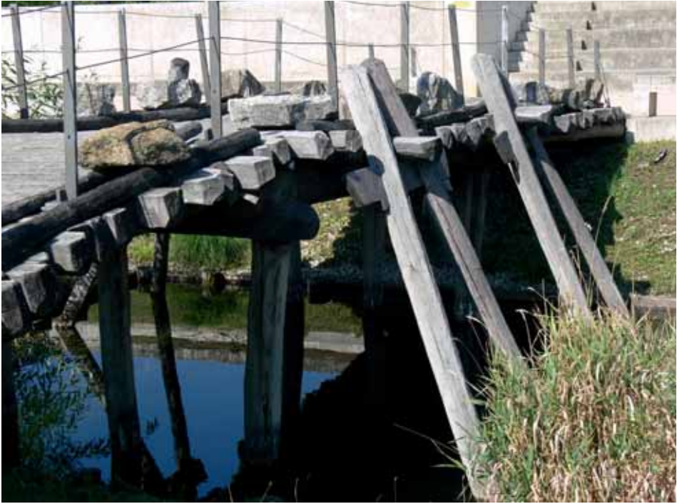
Ryc. 5. Rekonstrukcja mostu z Cornaux-les Sauges w Latenium, Hauterive/Neuchâtel. Szczegółowe rozwiązanie umocowania przypór ukośnych mostu. Fot. G. Wilke
