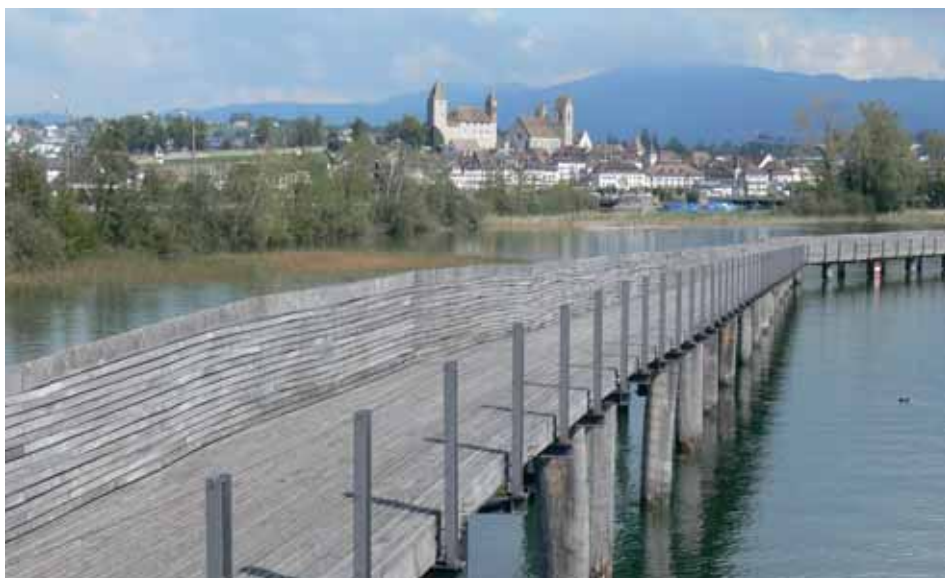
Ryc. 12. Rapperswil. Fragment zrekonstruowanego mostu. W tle widok średniowiecznego zamku i kościoła staromiejskiego. Fot. G. Wilke
