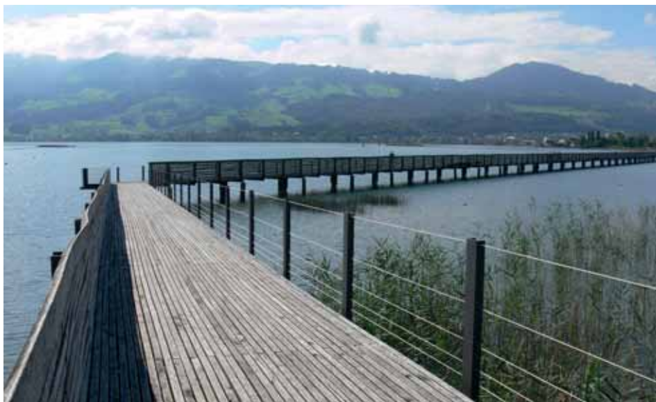
Ryc. 11. Rapperswil. Widok ogólny zrekonstruowanego mostu. Fot. G. Wilke
