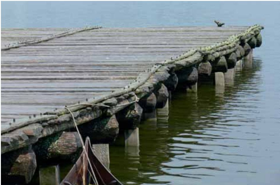
RYC. 14. Haithabu. Widok detaliczny na konstrukcję nośną pomostu portowego. Fot. G. Wilke
