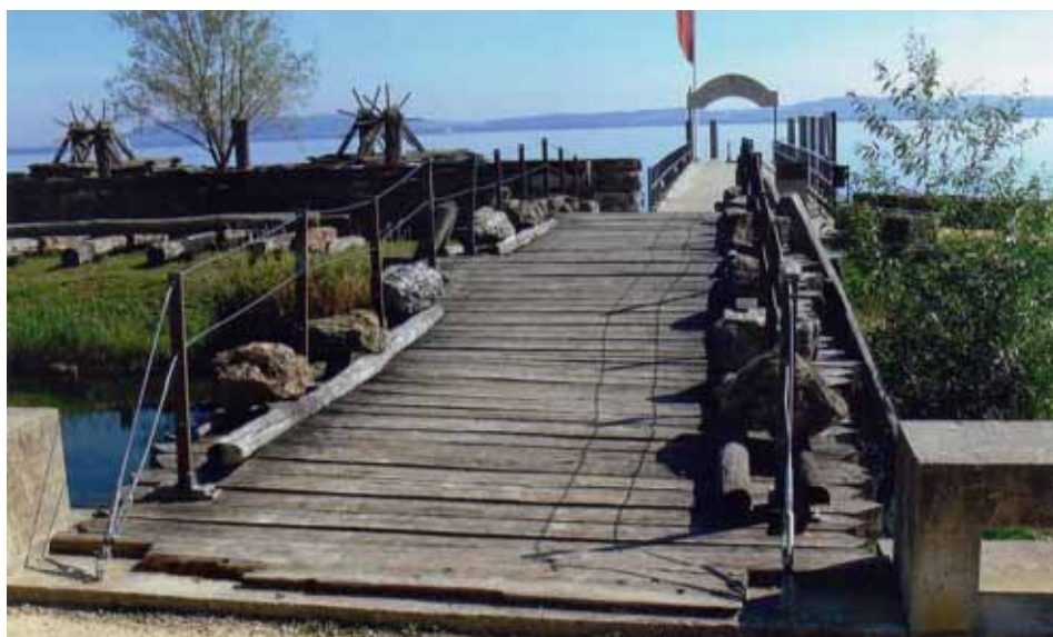
Ryc. 4. Rekonstrukcja mostu z Cornaux-les Sauges w Latenium, Hauterive/Neuchâtel. Widok na jezdnię mostową wraz z kamieniami stabilizującymi przeprawę. Fot. G. Wilke
