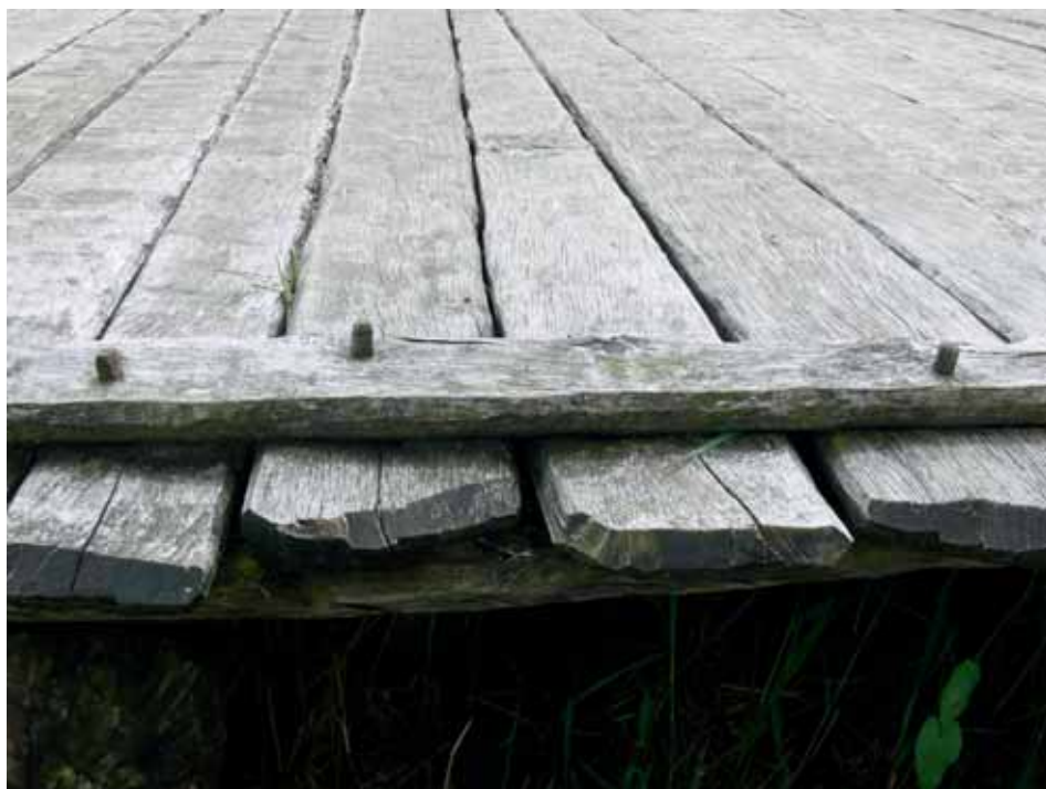
RYC. 15. Haithabu. Widok na umocowanie dranic nawierzchni pomostu portowego. Fot. G. Wilke FIG. 15. Haithabu. A view of the fixing of the hand cleft timber on the deck of the port pier. Photo by G. Wilke
