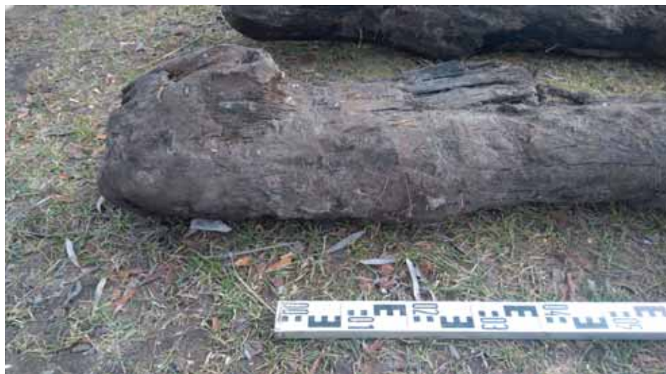
Ryc. 3. Belka nr 2. Zbliżenie na „hak”. Fot. P. Banaszak
