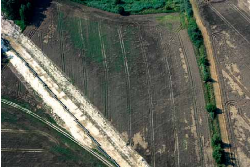
RYC. 2. Budowa gazociągu w woj. śląskim – fragment przecinający pole z widocznymi wyróżnikami roślinnymi po obu stronach inwestycji. Fot. P. Wroniecki
