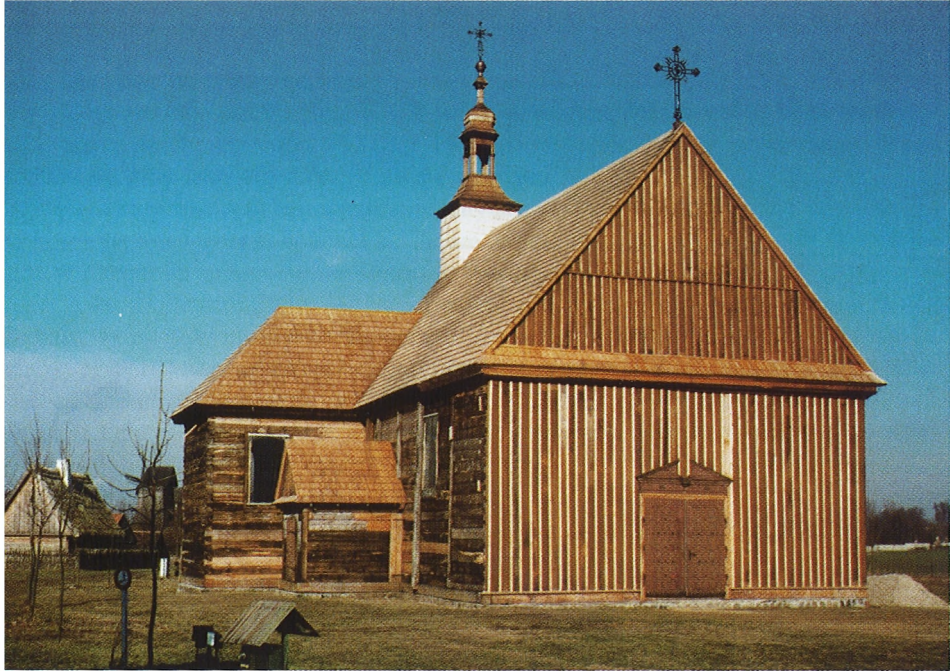
Ryc. 1. Montaż kościoła z Wartkowic. Abb. 1. Montage der Kirche aus Wartkowitz.
