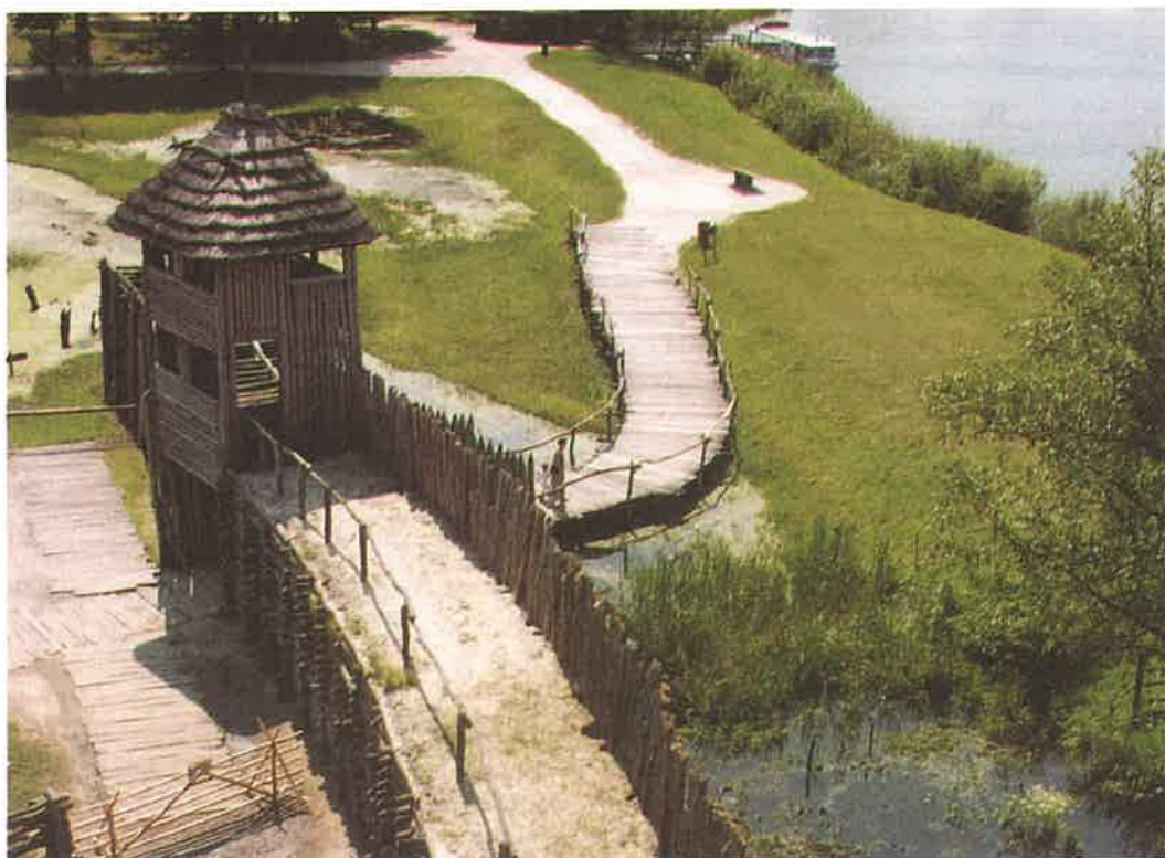
Ryc. 6. Fragment współczesnych rekonstrukcji w trakcie przebudowy — nowy odcinek wału. 2002 r. (fot. M. Kazik)
