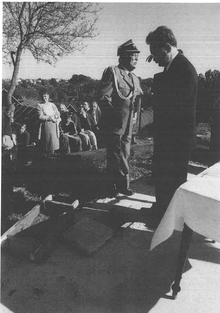
Foto. 1. Wmurowanie kamienia węgielnego pod budowę kościoła, 03. 05. 2000 r. (fot. A. Wrona).
