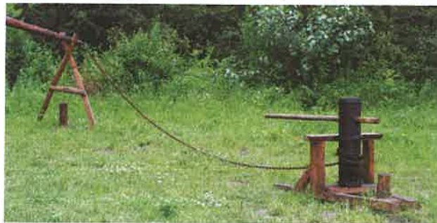
Fot. 1. Zrekonstruowany kołowrót do obracania wiatraka*
