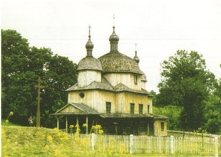
Foto. 1. Widok na cerkiew ze strony południowej, 1994 r.
