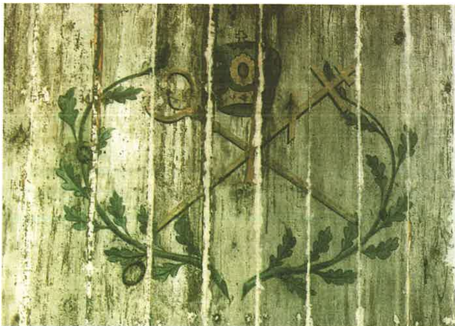
Foto. 7. Ściana nad arkadą łączącą babiniec z nawą. A. Przed konserwacją. B. Po konserwacji.
