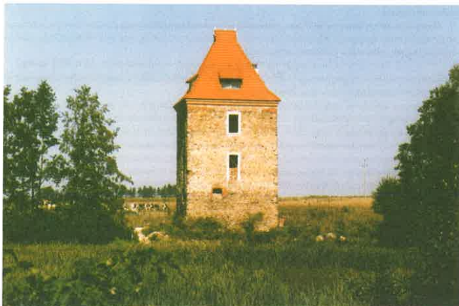
4. Dzierzychowice. Widok obecny wieży rycerskiej (fot. M. Magda-Nawrocka, R. Nawrocki — 2004)
