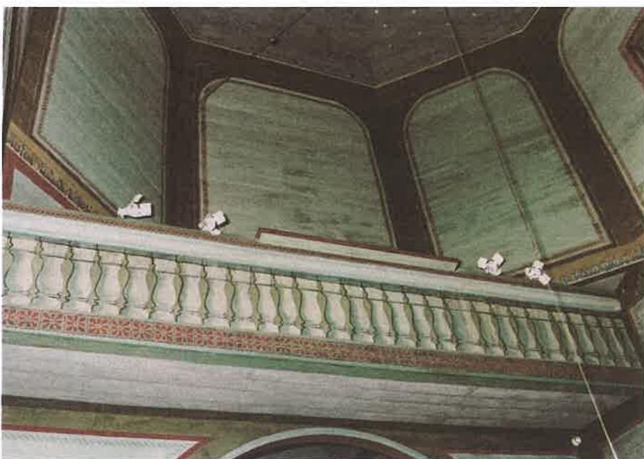
Foto 6 Wnętrze po konserwacji, górna strefa zachodniej ściany nawy i górnego chóru.
