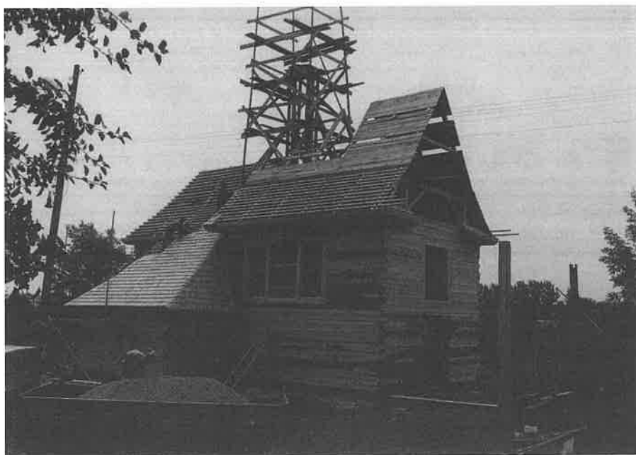
Foto. 3. Wybrane fazy montażu obiektu, lipiec 2000 r. (fot. K. Wasilczyk).
