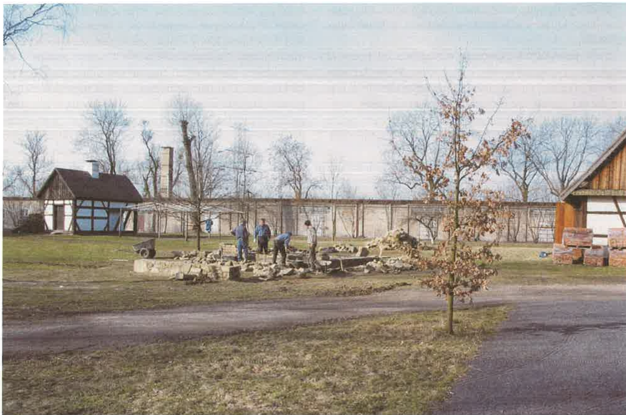
Fot. 7. Budowa podmurówki kamiennej bramy ze Starego Lasu
