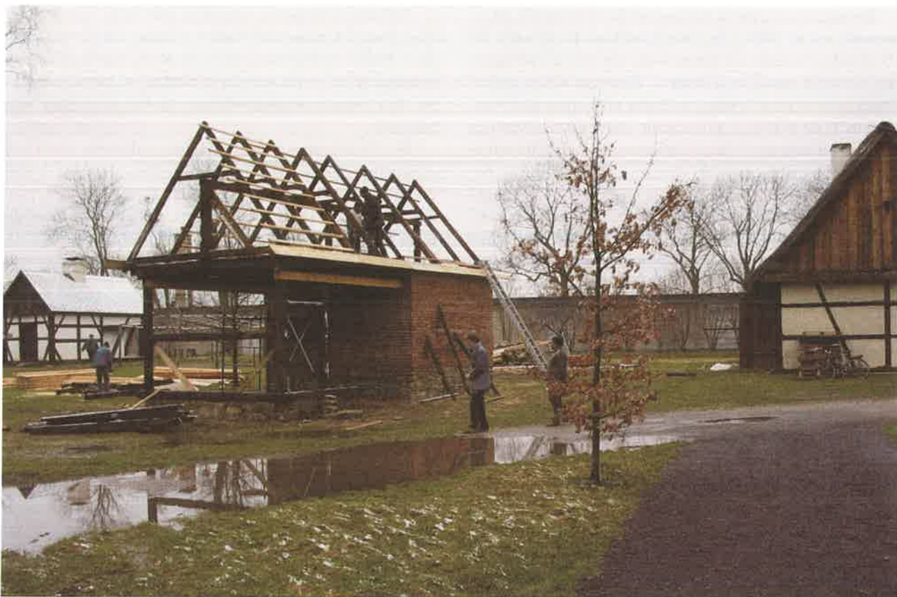
Fot. 9. Montaż więźby dachowej
