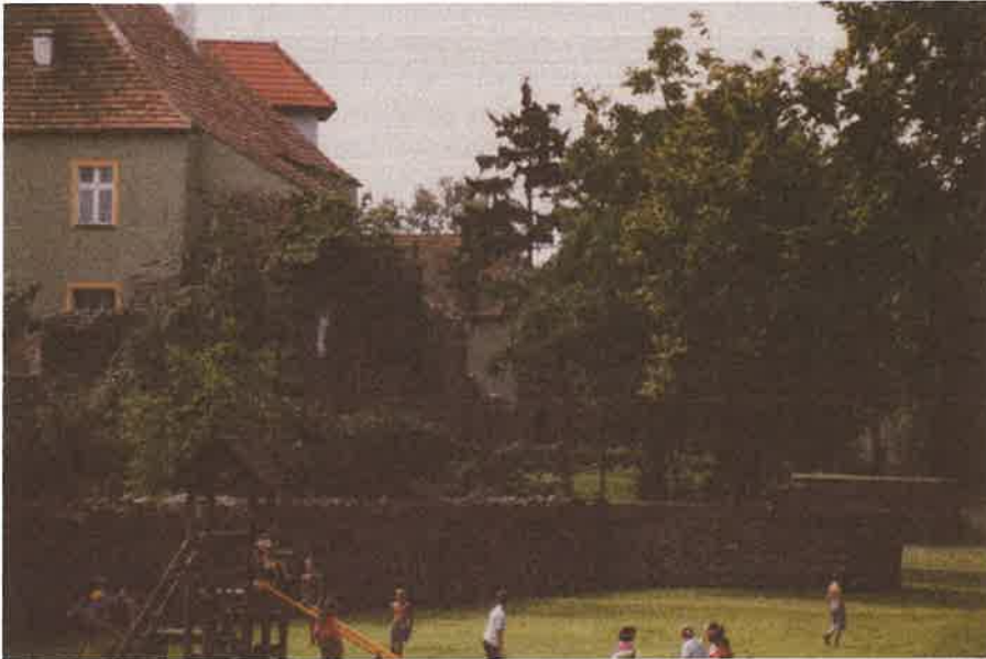
2. Koźuchów. Wewnętrzny i zewnętrzny pas murów obronnych (fot. M. Magda-Nawrocka, R. Nawrocki — 2004)
