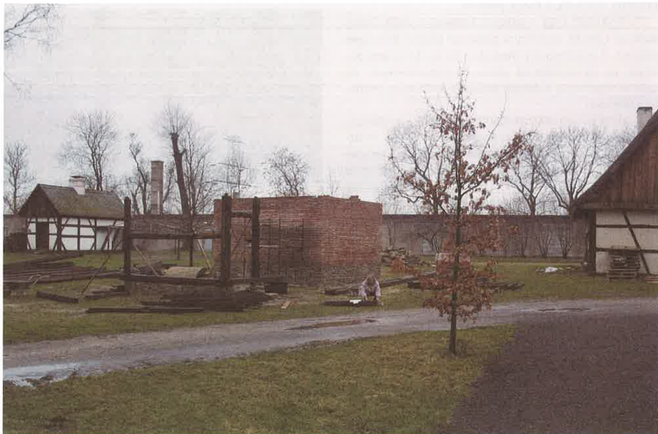
Fot. 8. Po wymurowaniu stajni rozpoczęto montaż elementów drewnianych
