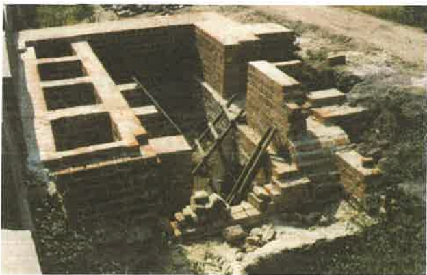
Fot. 6. Prace przy rekonstrukcji
