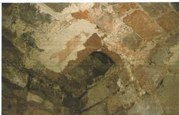
Fot. 5. Otwór zrzutowy wody z refektarza
