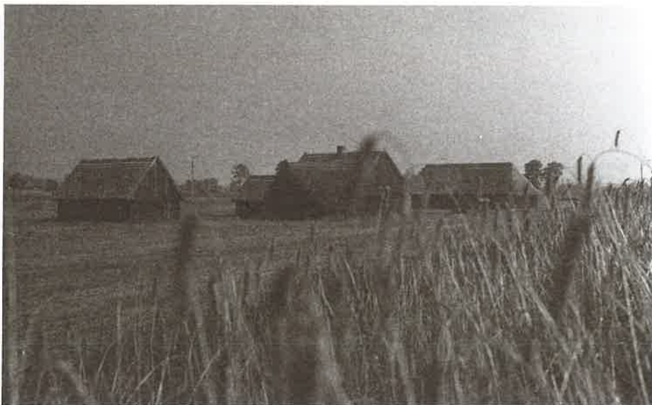
23. Fragment zabudowy WPE, początkowy etap realizacji, 1979 r., Archiwum MPP.
