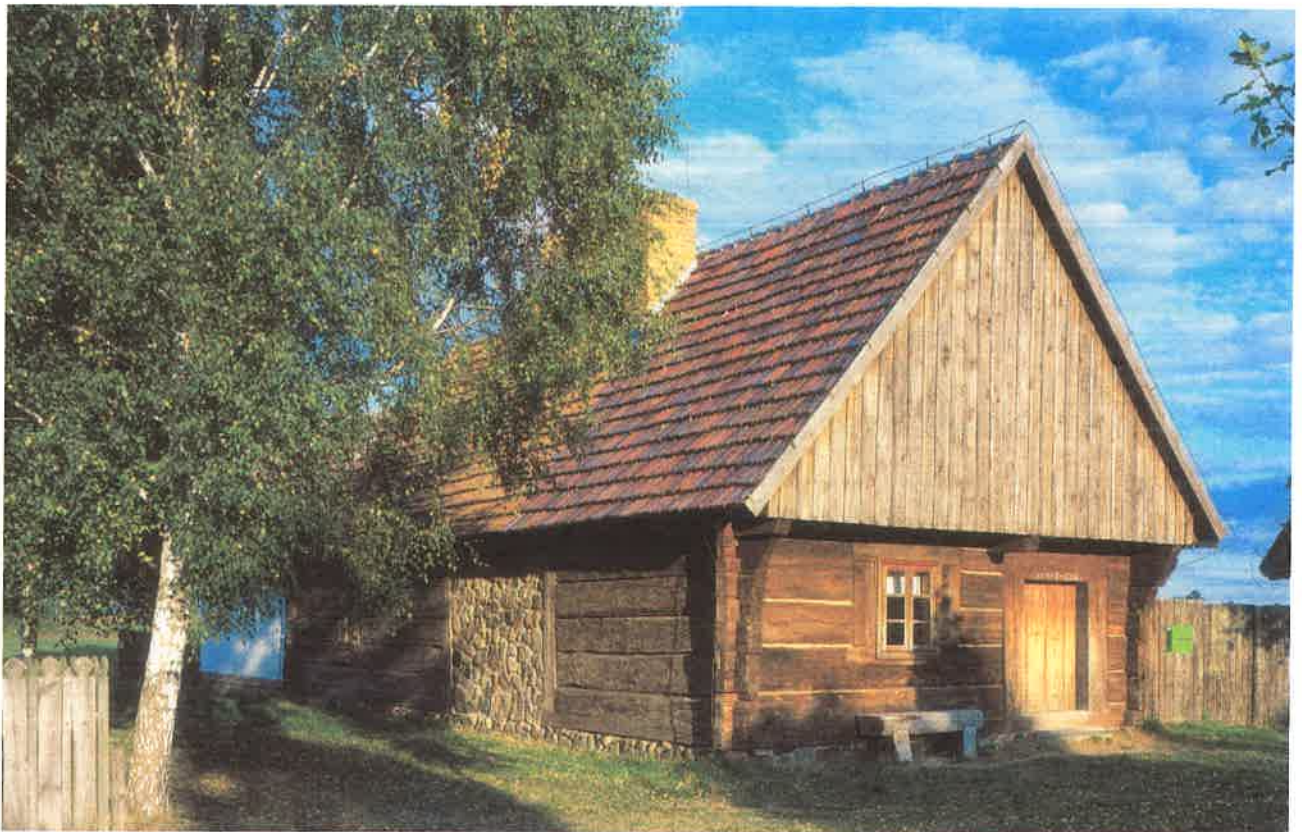
Fot. 22ab. Osiemnastowieczne chałupy podcieniowe: a) chałupa (1750 r.) wąskofrontowa, konstrukcji zrębowej z podcieniem bezsłupowym, przeniesiona z Sulmierzyc k/Krotoszyna, fot. Z. Wielgosz 2003 r.;
