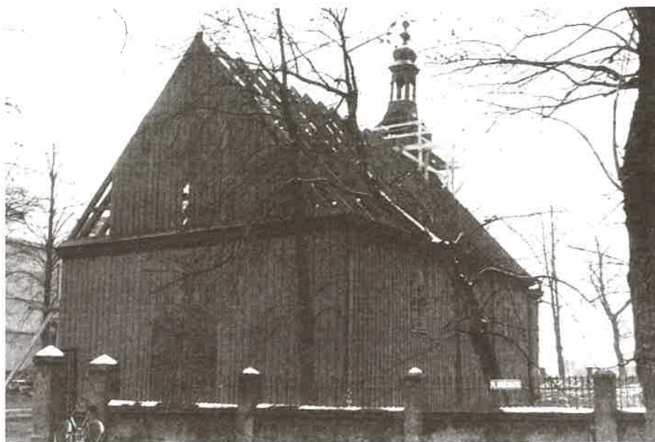
51. Kościół w Wartkowicach – prace rozbiórkowe, 1997 r., fot. M. Józwickowska.
