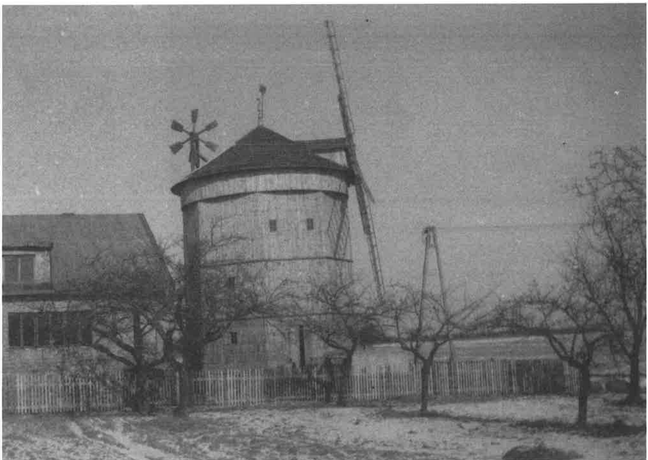
Fot. 18. abc. Ośmioboczny wiatrak (1905 r.) typu holender , chroniony in situ , Rogierówko k/Poznań: a) stan z 1941 roku (Archiwum MPP); b) stan z 1983 r. fot. A. Pelczyk; c) stan z 1987 r., fot. A. Kaszubkiewicz.
