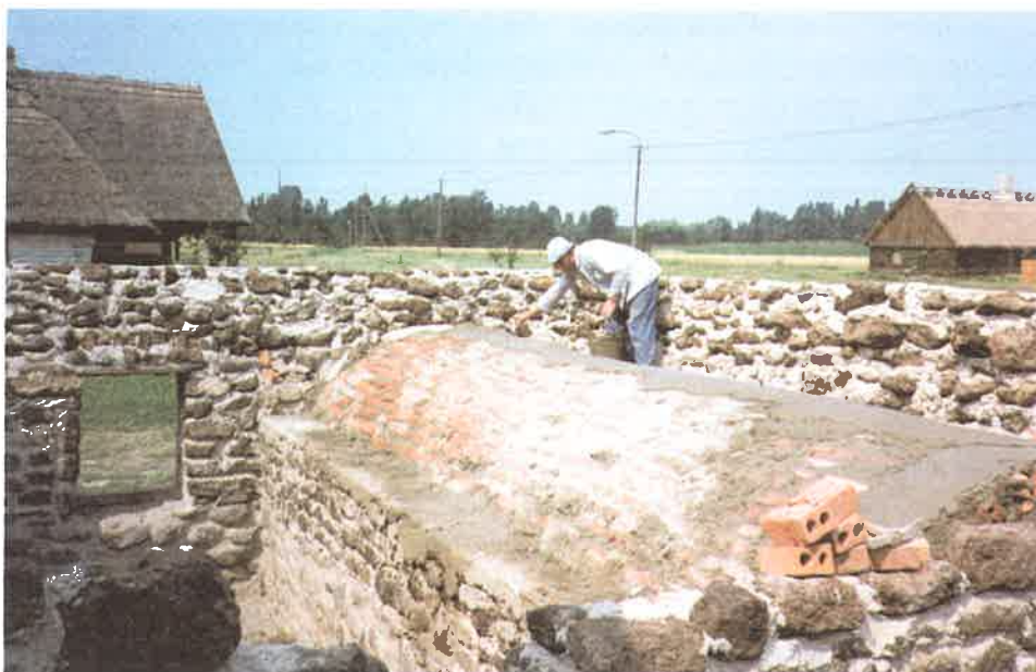
31. Montaż piwnicy z Końskiej Wsi w zagrodzie z Ołoboku, 1991 r., fot. A. Kaszubkiewicz.
