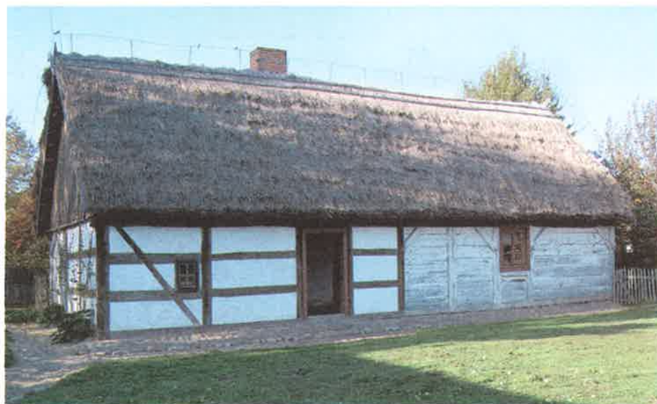
Fot. 4. Chałupa (1840 r.) szerokofrontowa symetryczna, konstrukcji mieszanej (sumikowo- łatkowa + szachulec), przeniesiona z Dzierżanowa k/Krotoszyna, fot. A. Pelczyk 2010 r.
