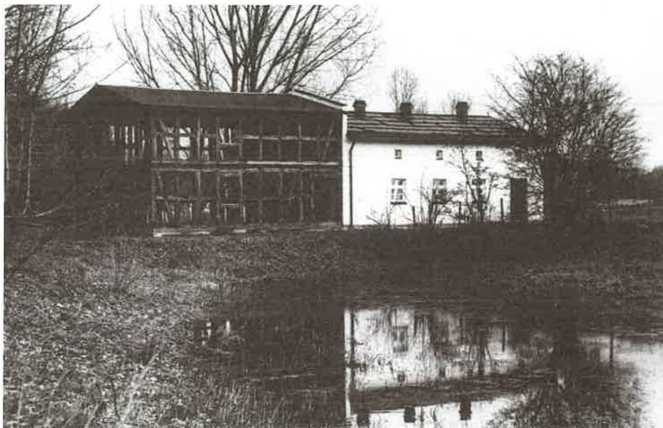
54. Młyn wodny z Wierzenicy – prace montażowe w WPE, 2002 r., Archiwum MPP.
