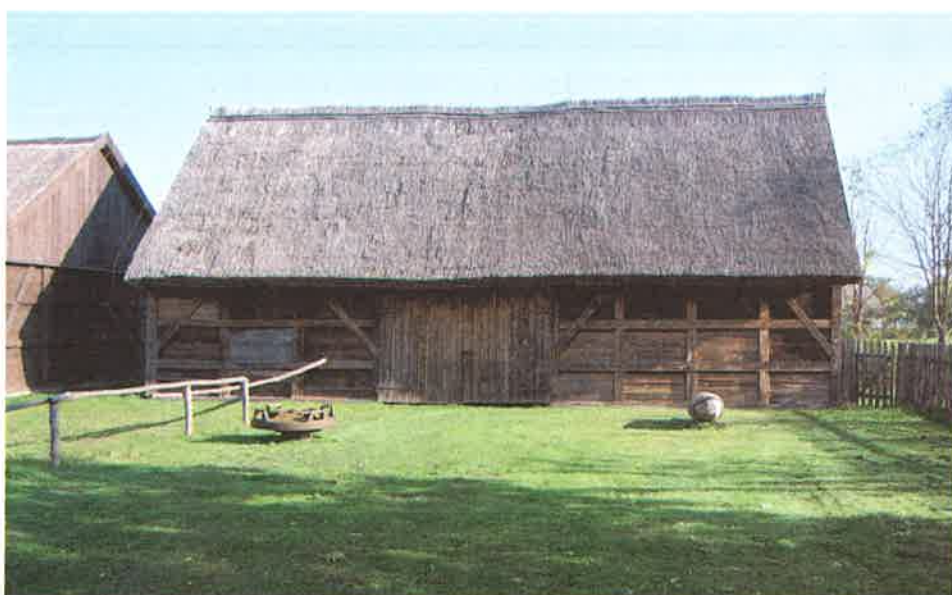
Fot. 6ab. Dziewiętnastowieczne stodoły ryglowe z Poznańskiego: a) pola drewnianej ramy wypełnione deskami, obiekt przeniesiony z Rogalina k/Poznań; b) pola ramy wypełnione drewnianymi żerdkami (strychulcami) oblepionymi gliną zmieszaną z siewką, obiekt przeniesiony z Fijałowa k/Krotoszyna, fot. A. Pelczyk 2010 r.
