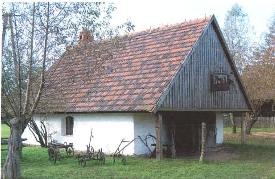
Fot. 7. Kuźnia (XIX w.), ściany z gliny, przeniesiona ze Skrzetusza k/Obomik Wlkp., fot. A. Pelczyk 2010 r.
