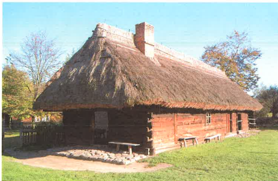
Fot. 5. Chałupa (1841 r.) wąskofrontowa, konstrukcji zrębowej na rybi ogon ze szczytowym podcieniem bezsłupowym, przeniesiona z Wolicy k/Kalisza, fot. A. Pelczyk 2010 r.
