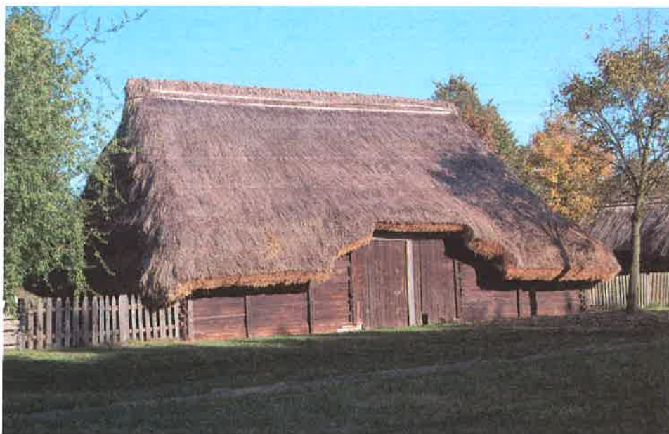
Fot. 24ab. Dziewiętnastowieczne stodoły przykryte czterospadowym dachem wspartym na sochach: a) stodoła (1885 r.) dwusochowa, przeniesiona z Godziesz Wielkich k/Kalisza, fot. A. Pelczyk 2010 r.;
