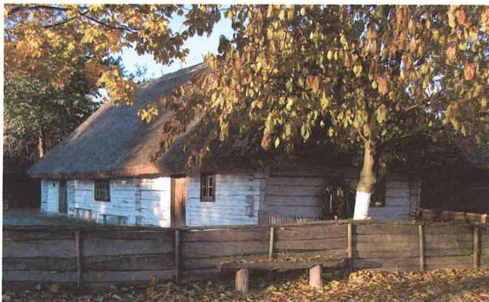
Fot. 9. Chałupa (pocz. XIX w.) szerokofrontowa asymetryczna, konstrukcji zrębowej na obłap ze ślepym bezsłupowym podcieniem szczytowym, przeniesiona z Ołoboku k/Ostrowa Wlkp., fot. A. Pelczyk 2010 r.
