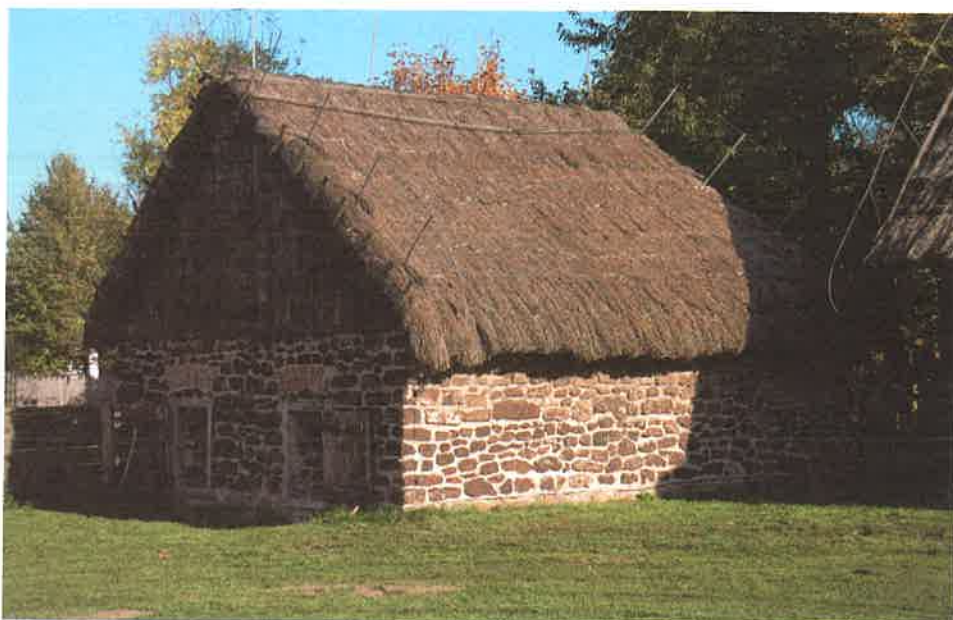
Fot. 12. Piwnica (XIX w.) wolno stojąca, dwukomorowa, wzniesiona z rudy darniowej, przeniesiona z Końskiej Wsi k/Kalisza, fot. A. Pelczyk 2010 r.
