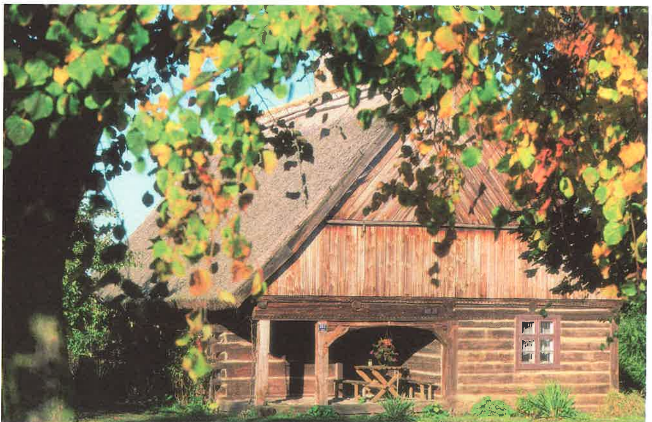
b) chałupa (1737r.), wąskofrontowa z narożnym podcieniem wnąkowym, przeniesiona z Marianowa k/Wielenia, fot. Z. Wielgosz 2003 r.
