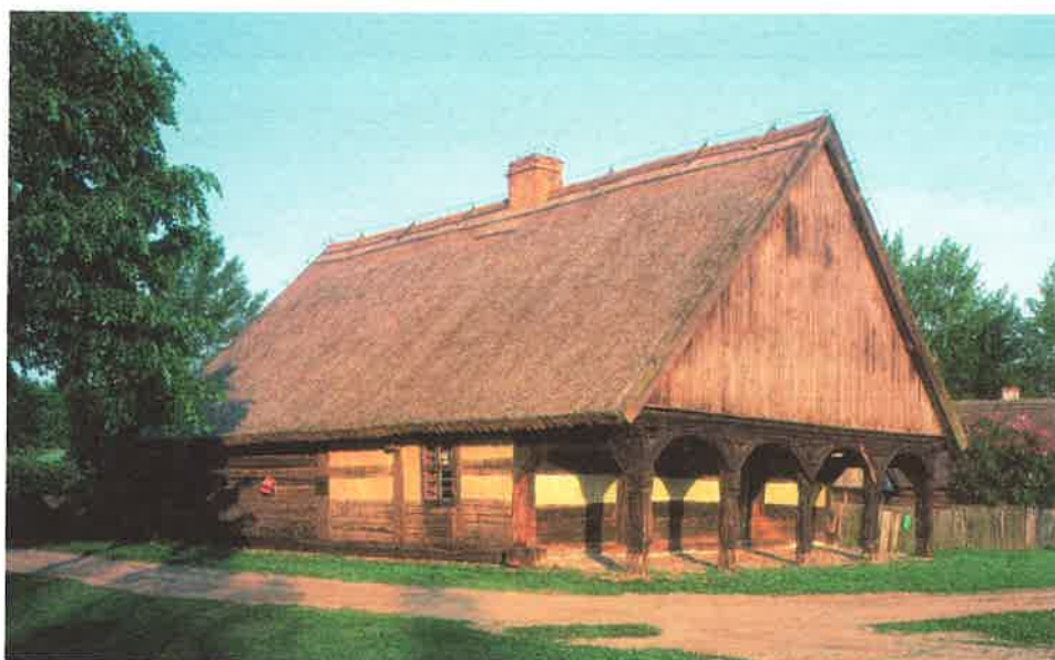
Fot. 8. Karczma (dom z wyszynkiem, kon. XVIII w.), z pięciosłupowym podcieniem szczytowym, przeniesiona z Sokołowa Budzyńskiego k/Chodzieży, fot. Z. Wielgosz 2003 r.
