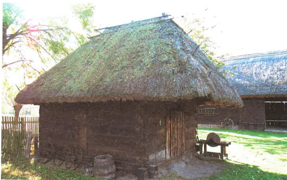
Fot. 13ab. Dziewiętnastowieczne spichlerze chłopskie z Kaliskiego: a) spichlerz ( solek ) z podcieniem bezsłupowym ( przypalem ), przeniesiony z Godziesz Wielkich k/Kalisza, fot. A. Pelczyk;
