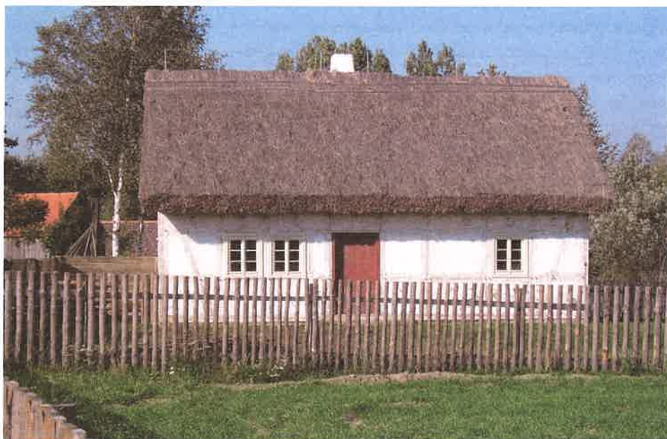
56. Dom z Zielonej Wsi – etap po zakończeniu prac montażowych, 2004 r., Archiwum MPP.
