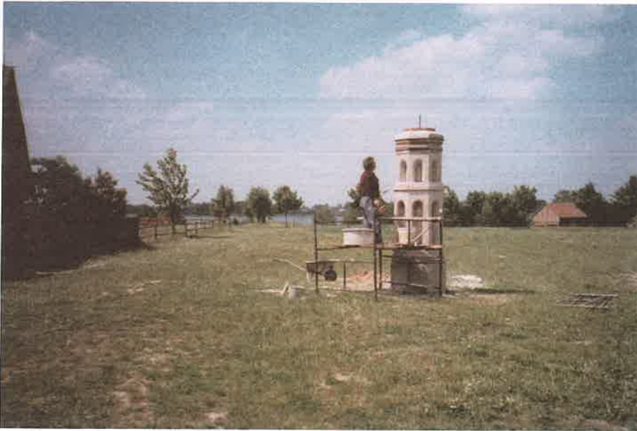
49. Kapliczka słupowa św. Roch – budowa trzonu, 1993 r., fot. A. Kaszubkiewicz.
