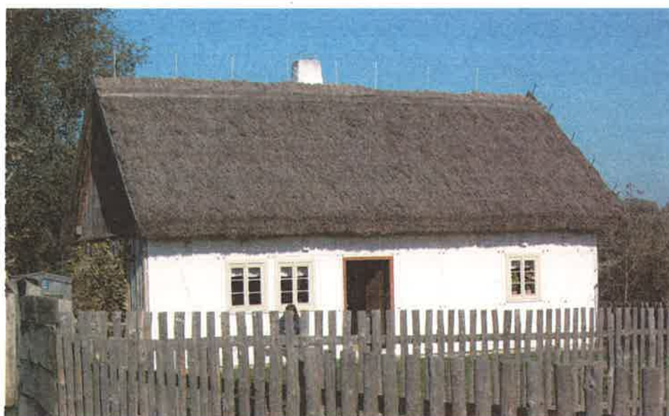
Fot. 3. Chałupa (XIX w.) szerokofrontowa symetryczna, konstrukcji szkieletowej – szachulec, przeniesiona z Zielonej Wsi k/Rawicza (Chazy), fot. A. Pelczyk 2010 r.
