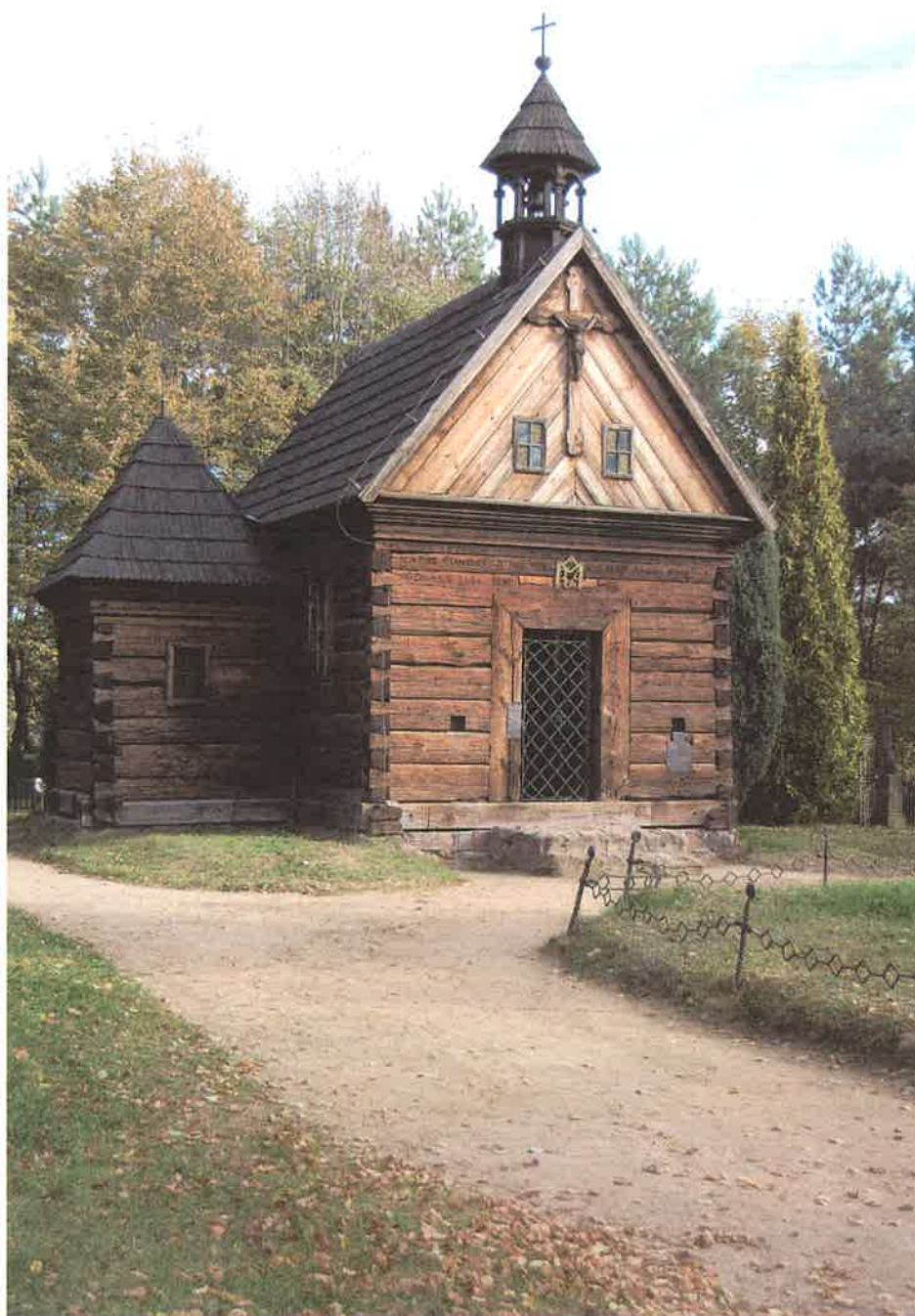
Fot. 23. Kaplica (1765 r.), konstrukcji zrębowej na rybi ogon , przeniesiona z Otłoczyna k/ Aleksandrowa Kujawskiego, fot. A. Pelczyk 2010 r.
