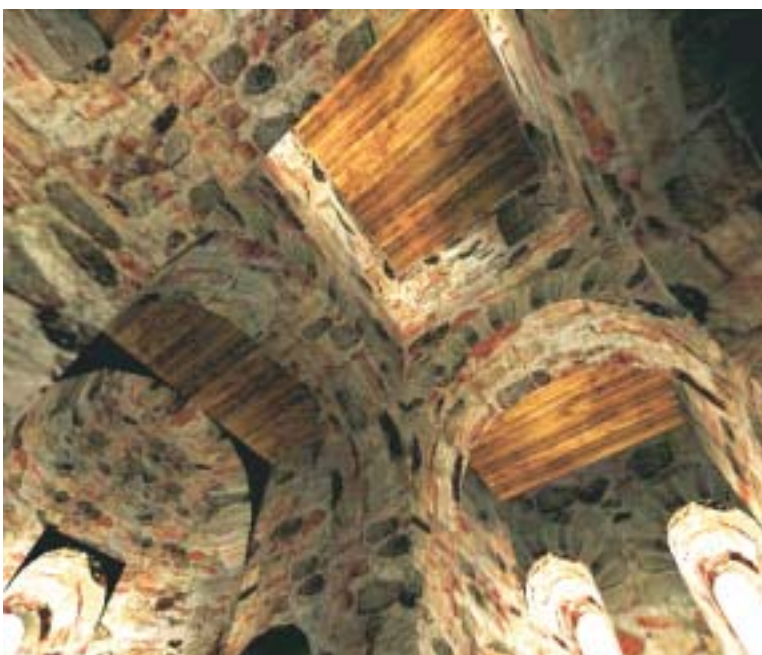
Rys. 84. Sklepienia i sufity w baptysterium. Po lewej stronie przerwane sklepienie nad absydą, po prawej sufit nad południowym ramieniem krzyża. (opracował autor)
