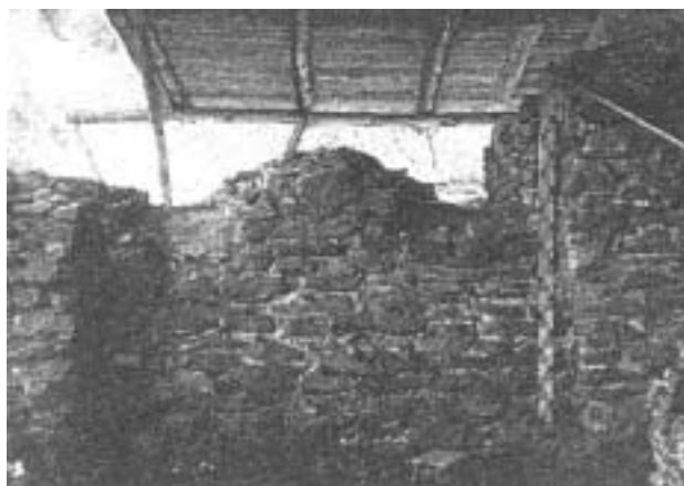
Rys. 103. Drewniane, tymczasowe zadaszenie osłaniające ruiny. Zdjęcie za: Dalbor W. (1957 – 59)
