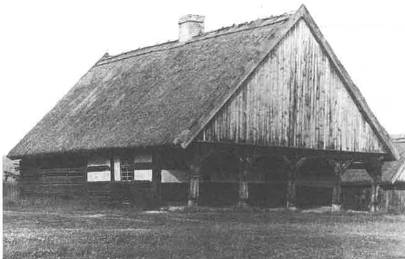
Ryc. 30. Dom (XVIII w.) z wyszynkiem (karczma), wąskofrontowy, z podcieniem pięciostupowym, Sokołowo Budzyńskie, gm. Budzyń. Obiekt przeniesiony do WPE. Fot. A. Pelczyk, 1988 r.
