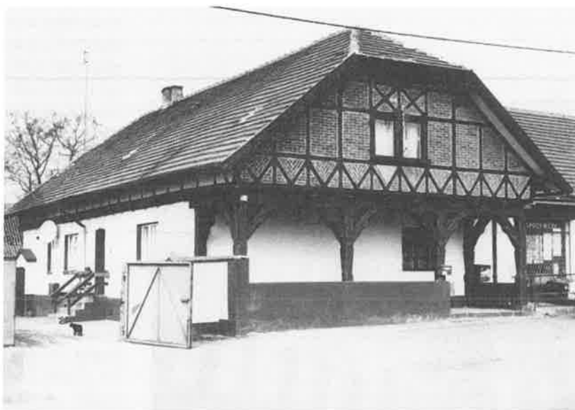
Ryc. 15. Dom (XIX w.) murowany z cegły palonej ze szczytowym podcieniem słupowym. Szczyt dachu naczółkowego zamknięty ścianą konstrukcji ryglowej wypełnionej cegłą paloną (mur pruski), Owieczki, gm. Łubowo. Fot. A. Ziółkowski, 2002 r.
