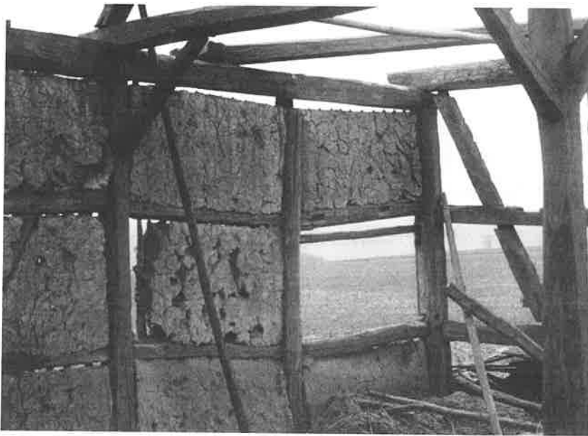
Ryc.9. Fragment konstrukcji ryglowej (szachulecowej). W polach drewnianej kratownicy wyraźnie widoczne żerdki (szczęble) oblepione gliną. Krobia Stara, gm. Krobia. Fot. M. Krężałek, 1981 r.
