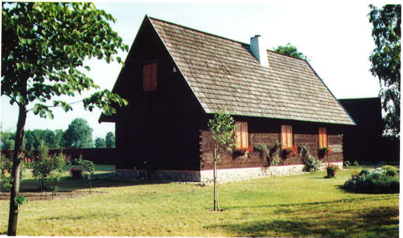
Ryc. 42. Ochrona XIX-wiecznego obiektu poprzez translokację i adaptację na dom letniskowy. Bednary, gm. Pobiedziska. Fot. A. Ziółkowski, 2000 r.
