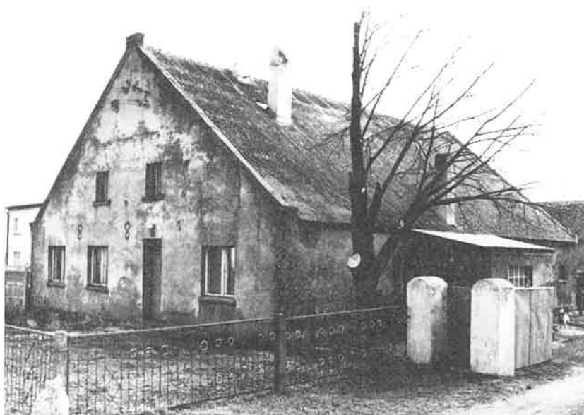
Ryc. 16. Typ domu murowanego (1889 r.) z częścią mieszkalną i gospodarczą pod jednym dachem, Łubowo. Obiekt bardzo popularny pod koniec XIX w. na Pojezierzu Gnieźnieńskim. Fot. A. Ziółkowski, 2002 r.
