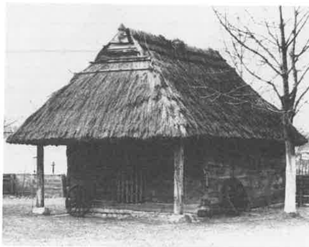
Ryc. 5. Typy wolno stojących, zrębowych spichlerzy chłopskich (sołków) przeniesionych z Kaliskiego do WPE. a) spichlerz (XIX w.) z podcieniem bezszlupowym (przyłapem), Godziesze Wielkie. Fot. A. Ziółkowski, 2002 r.; b) spichlerz (XIX w.) z podcieniem dwuszlupowym, Wrząca, gm. Brzeziny. Fot. A. Ziółkowski, 2002 r.
