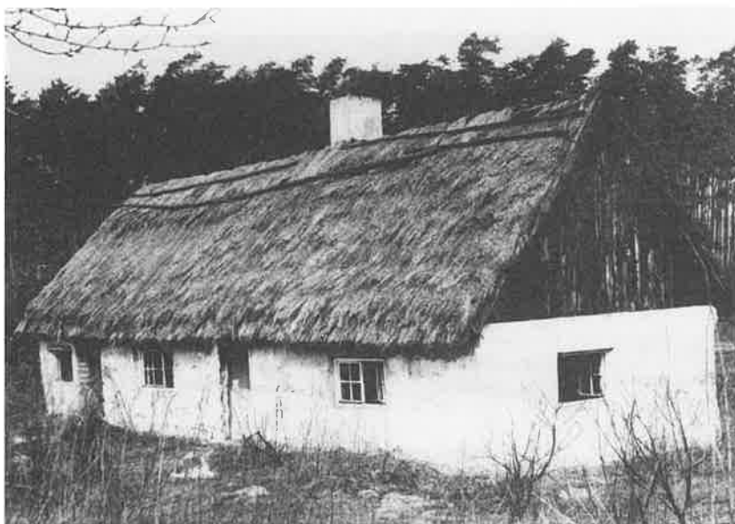
Ryc. 14. Chałupa szerokofrontowa, symetryczna (1843 r.) o ścianach glinobitych, Świątniki, gm. Mosina. Fot. A. Pelczyk 1988 r.
