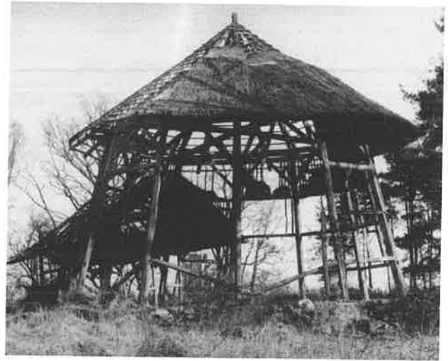
Ryc. 44. Całkowite zniszczenie obiektu poprzez utratę funkcji użytkowej. Stodoła (XIX w.) konstrukcji szkieletowej pierwotnie wypleciona słomianymi warkoczami, Mycielín, gm. Koźmin: a) stan z I poł. XX w. Arch. MPP na Lednicy; b) stan z 1989 r. Fot. M. Krężałek, 1989 r.
