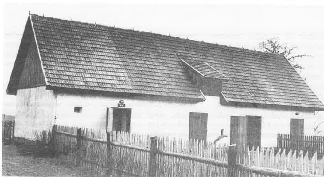
Ryc. 63. Budynek inwentarski, murowany z glinianej pecy, Gałęzewo, gm. Rogowo: a) oryginał in situ. Fot. A. Pelczyk; b) rekonstrukcja w WPE. Fot. A. Ziółkowski, 2002 r.
