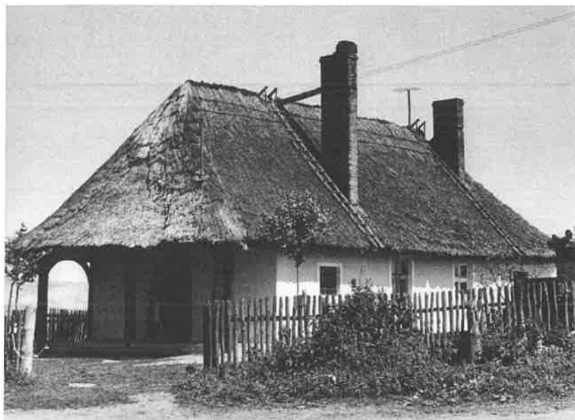
Ryc. 21. Dom (XVIII w.) z dachem czterospadowym (stan z 1979 r.), Wierzenica, gm. Swarzędz. Fot. J. Pic. Archiwum MPP na Lednicy.
