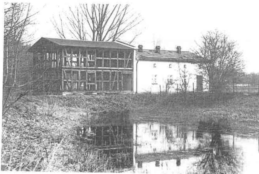
Ryc. 70. Lokalizacja młyna wodnego (XIX w.) w WPE. Obiekt przeniesiony do WPE z Wierzenicy, gm. Swarzędz. Do młyna, położonego na skraju działki sąsiadującej z działką gminną, przylega kopia murowanej młynarzówki, w której zamontowano urządzenia wiejskiej oczyszczalni ścieków. Fot. A. Ziółkowski, 2002 r.
