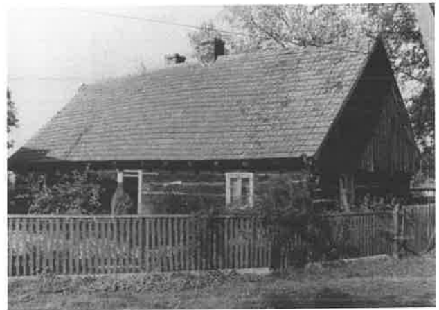
Ryc. 7. Typy chałup olęderskich w Nowotomyskiem: a) dom (XIX w.) konstrukcji zrębowej z tępem, szerokofrontowy, symetryczny, Jastrzębsko Stare, gm. Nowy Tomyśl. Fot. M. Jóźwikowska, 1995; b) dom konstrukcji zrębowej, szerokofrontowy, symetryczny, Sątopy, gm. Nowy Tomyśl. Fot. A. Pelczyk, 1999 r.
