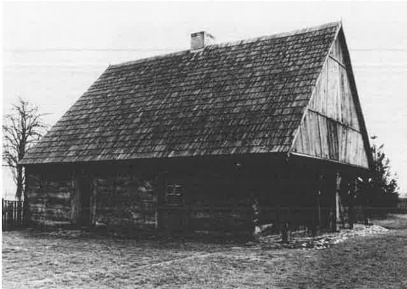
Ryc. 62. Rekonstrukcja domu (ok. 1800 r.) z oryginalnym podcieniem pięciosłupowym, Lubczynek, gm. Rogowo. Obiekt zaadaptowany na kasę WPE, dozorcówkę oraz mały punkt gastronomiczny. Fot. A. Ziółkowski, 2002 r.
