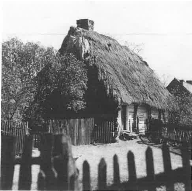
Ryc.18. Chałupa szerokofrontowa, asymetryczna o ścianach konstrukcji zrębowej z osłatkami. Budynek nakryty wysokim, stromym dachem czterospadowym, Mieleszówka, gm. Doruchów. Fot. Zb. Zawadzki, 1950 r. Arch. MPP na Lednicy.
