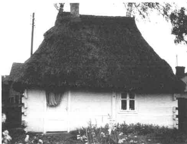
Ryc. 40. Dom (XIX w.) zrębowy, jednoizbowy z sienią nieprzechodnią, Dobrzec, gm. Nowe Skalmierzyce. Fot. A. Piasecka 1980 r.
