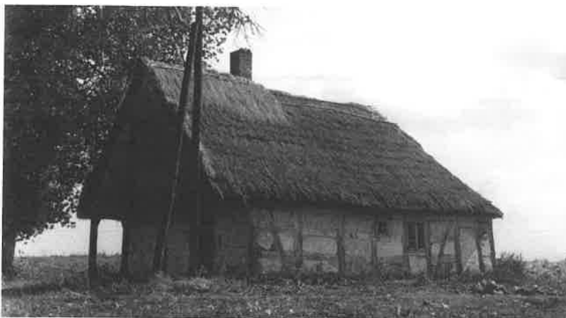
Ryc. 28. Dom wąskofrontowy z podcieniem słupowym, Potulice, gm. Wągrowiec. Fot. St. Błaszczyk, 1966 r. Arch. MPP na Lednicy.
