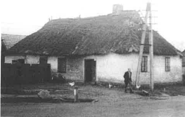
Ryc.19. Karczma (XVIII w.) wzniesiona w konstrukcji zrębowej wtórnice polepionej gliną. Obiekt nakryty dachem czterospadowym, Przykona, gm. Przykona. Fot. M. Krężałek, 1975 r.
