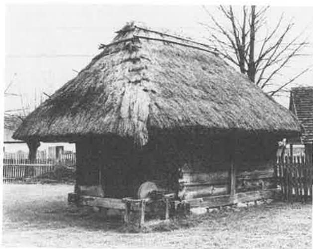
Ryc. 5. Typy wolno stojących, zrębowych spichlerzy chłopskich (sołków) przeniesionych z Kaliskiego do WPE. a) spichlerz (XIX w.) z podcieniem bezszlupowym (przyłapem), Godziesze Wielkie. Fot. A. Ziółkowski, 2002 r.; b) spichlerz (XIX w.) z podcieniem dwuszlupowym, Wrząca, gm. Brzeziny. Fot. A. Ziółkowski, 2002 r.
