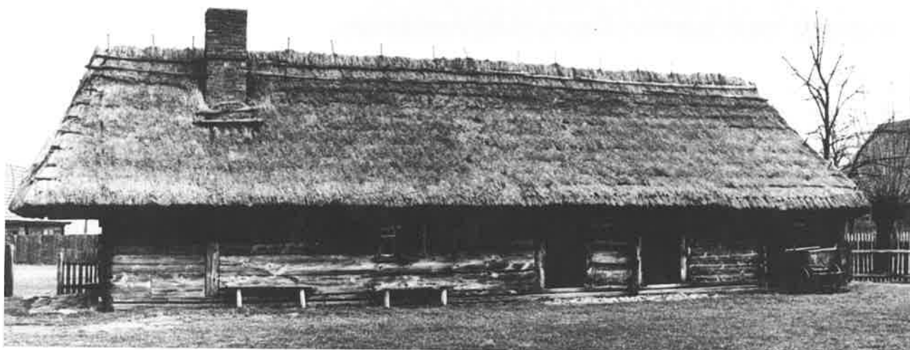
29a. Dom (1841 r.) zrębowy z podcieniem bezsłupowym (przyłapem), wąskofrontowy, jednoizbowy z sienią, izbą i komorą w układzie amfiladowym oraz pomieszczeniami gospodarczymi pod wspólnym dachem. Obiekt przeniesiony z Wolicy, gm. Godziesze Wielkie do WPE. Fot. A. Ziółkowski, 2002 r.
