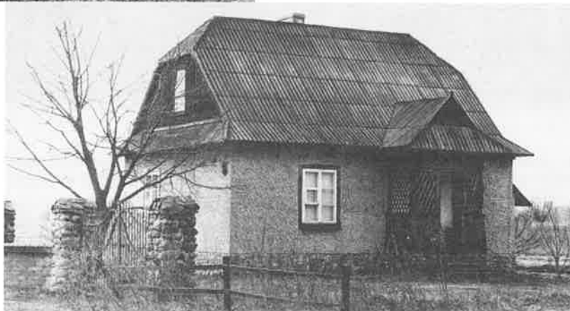
Ryc. 23b. Typ domu mieszkalnego z parcelacji rządowej w latach 30-tych XX w. Przykład ochrony domu poprzez translokację w inne miejsce z zachowaniem pierwotnej funkcji użytkowej. Obiekt drewniany, otynkowany, przeniesiony ze Skrzetuszewa, gm. Kiszkowo do Lednogóry, gm. Łubowo. Fot. A. Ziółkowski, 2002 r.
