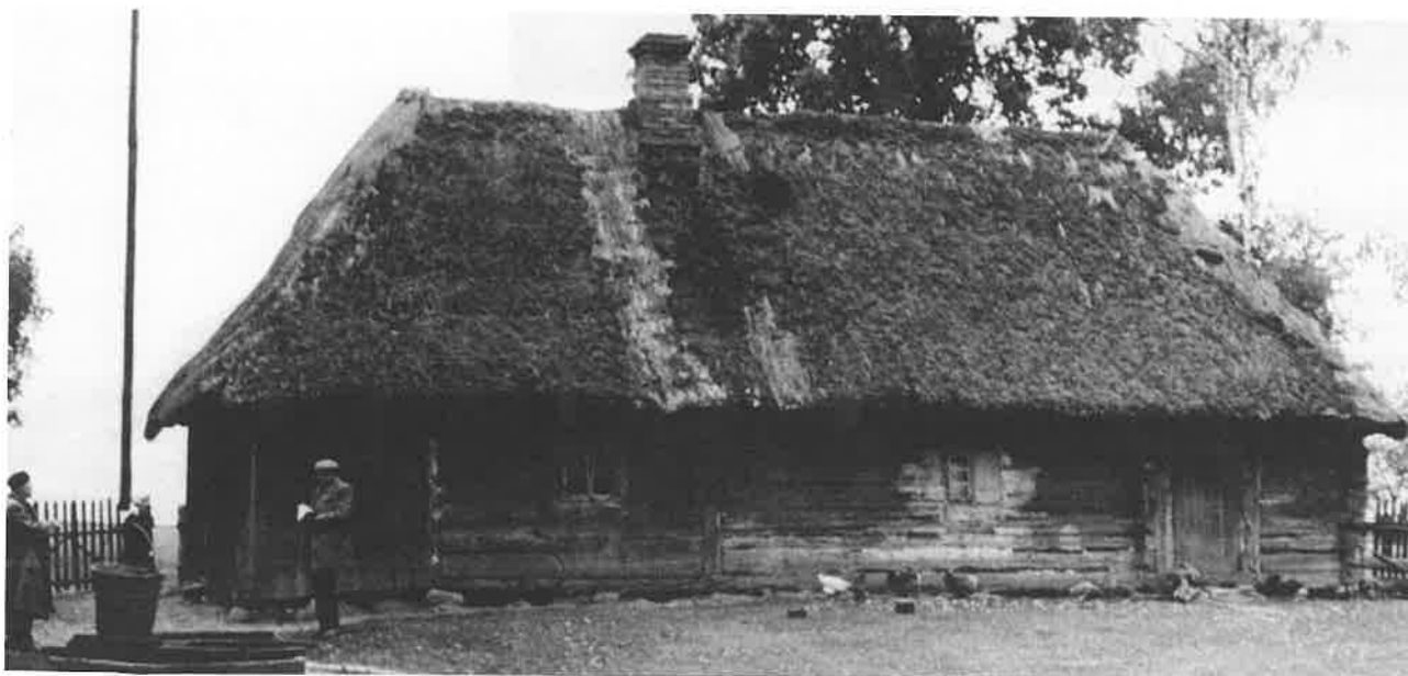
29b. Dom (XIX w.) zrębowy z wtórnie zabudowanym podcieniem bezsłupowym (przyłapem), wąskofrontowy, jednoizbowy. Zagórna, gm. Brzeziny. Fot. T. Wróblewski, lata 50-te XX w. Arch. MPP na Lednicy.
