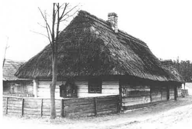
Ryc. 32. Dom (XIX w.) szerokofrontowy, asymetryczny z tzw. ślepym podcieniem, Ołobok, gm. Sieroszewice. Obiekt przeniesiony na teren WPE. Fot. A. Ziółkowski, 2002 r.
