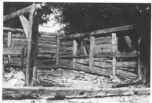
Ryc. 11. Stodoła (1801 r.) konstrukcji ryglowej wypełnionej dranicami (stan w trakcie rozbioru), Dąbrówka Kościelna, gm. Kiszkowo. Obiekt przeniesiony do Punktu etnograficznego w Moraczewie, gm. Łubowo. Fot. A. Pelczyk, 1989 r.
