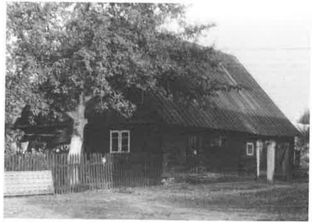
Ryc. 36. Dom (1807 r.) zrębowy, szerokofrontowy, asymetryczny z częścią inwentarską pod jednym dachem, Sątopy, gm. Nowy Tomyśl. Fot. M. Józwickowska, 1995 r.
