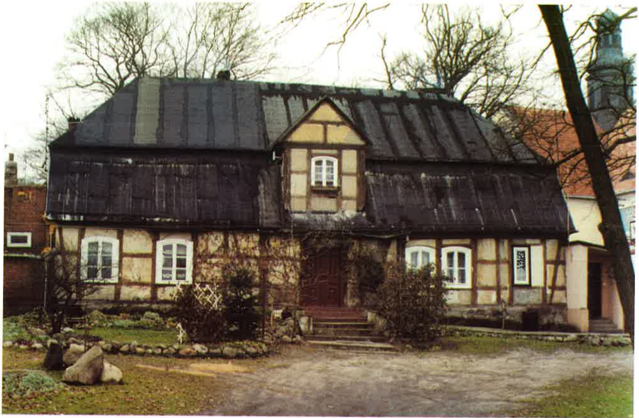
Ryc. 41. Ochrona obiektu in situ poprzez zachowanie funkcji mieszkalnej. Dawna plebania (XVIII w.), Komorniki, gm. Komorniki. Fot. A. Pelezyk, 2001 r.
