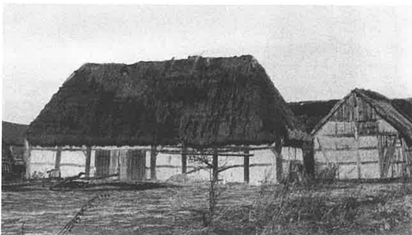
Ryc. 20 Budynki gospodarcze konstrukcji ryglowej (szachulcowej), Żychlewo, gm. Krobia. Na pierwszym planie stodoła (1775 r.) nakryta dachem czterospadowym. Fot. St. Błaszczyk, 1956 r. Arch. MPP na Lednicy.
