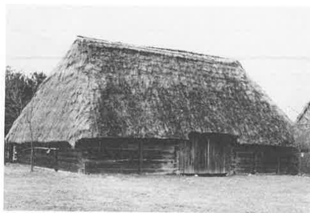
Ryc. 25. Stodoła (1885 r.) konstrukcji zrębowej, nakryta dachem czterospadowym wspartym na dwóch sochach ze śłemeniem, Dobrzec, gm. Nowe Skalmierzyce: a) w trakcie montażu w WPE. Fot. M. Krężałek, 1981 r.; b) po montażu. Foto A. Ziółkowski, 2002 r.
