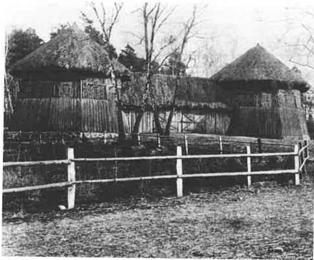
Ryc. 44. Całkowite zniszczenie obiektu poprzez utratę funkcji użytkowej. Stodoła (XIX w.) konstrukcji szkieletowej pierwotnie wypleciona słomianymi warkoczami, Mycielín, gm. Koźmin: a) stan z I poł. XX w. Arch. MPP na Lednicy; b) stan z 1989 r. Fot. M. Krężałek, 1989 r.
