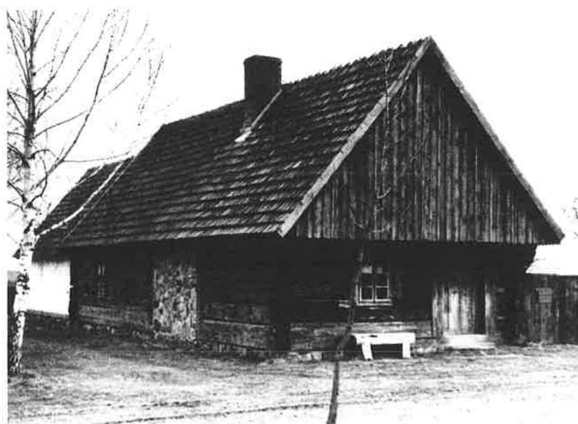
Ryc. 75. Dom (1750 r.) z podcieniem bezsłupowym wspartym na rysiach, Sulmierzyce. a) stan przed rozbiórką. Fot. T. Wróblewski, 1950 r.; b) stan po translokacji do WPE. Fot. A. Ziółkowski, 2002 r.
