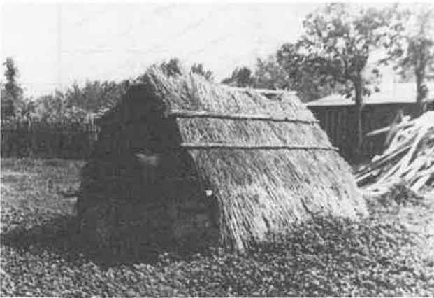
Ryc. 4. Typy piwnic wolno stojących: a) piwnica wąskofrontowa, dwukomorowa, murowana z rudy darniowej, pod dachem trzyspadowym, Końska Wieś, gm. Godziesze Wielkie. Fot. A. Pelczyk, 1988; b) piwnica szerokofrontowa, dwukomorowa, murowana z cegły palonej, pod dachem dwuspadowym, Końska Wieś, gm. Godziesze Wielkie; c) piwnica wąskofrontowa, jednokomorowa, murowana z cegły palonej, zadaszona, Niałek Wielki, gm. Wolsztyn. Fot. St. Błaszczyk, 1956 r.
