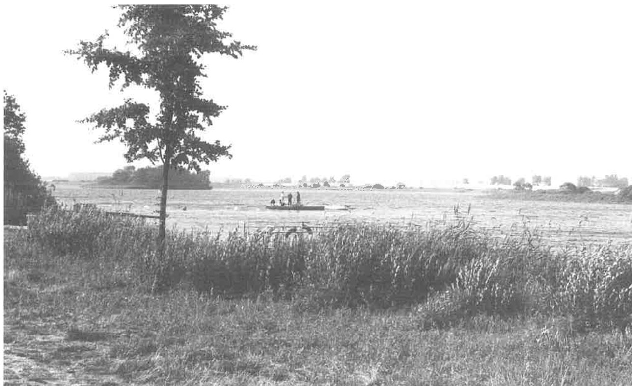
Ryc. 11. Platforma asekuracyjno-techniczna w rejonie badań podwodnych na reliktach mostu „gnieźnieńskiego” (fot. W. Najder). Fig. 11. Safety-technical platform in the area of underwater survey of the Gniezno bridge (photo W. Najder).
