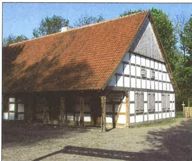
Il. 29. Kopia karczmy ze Skandawy. Stan po konserwacji, fot. M. Poniewski.
