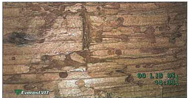
Il. 7. Widok powierzchni drewna dotkniętego brunatnym rozkładem z żerówkami kołatkowatych.
