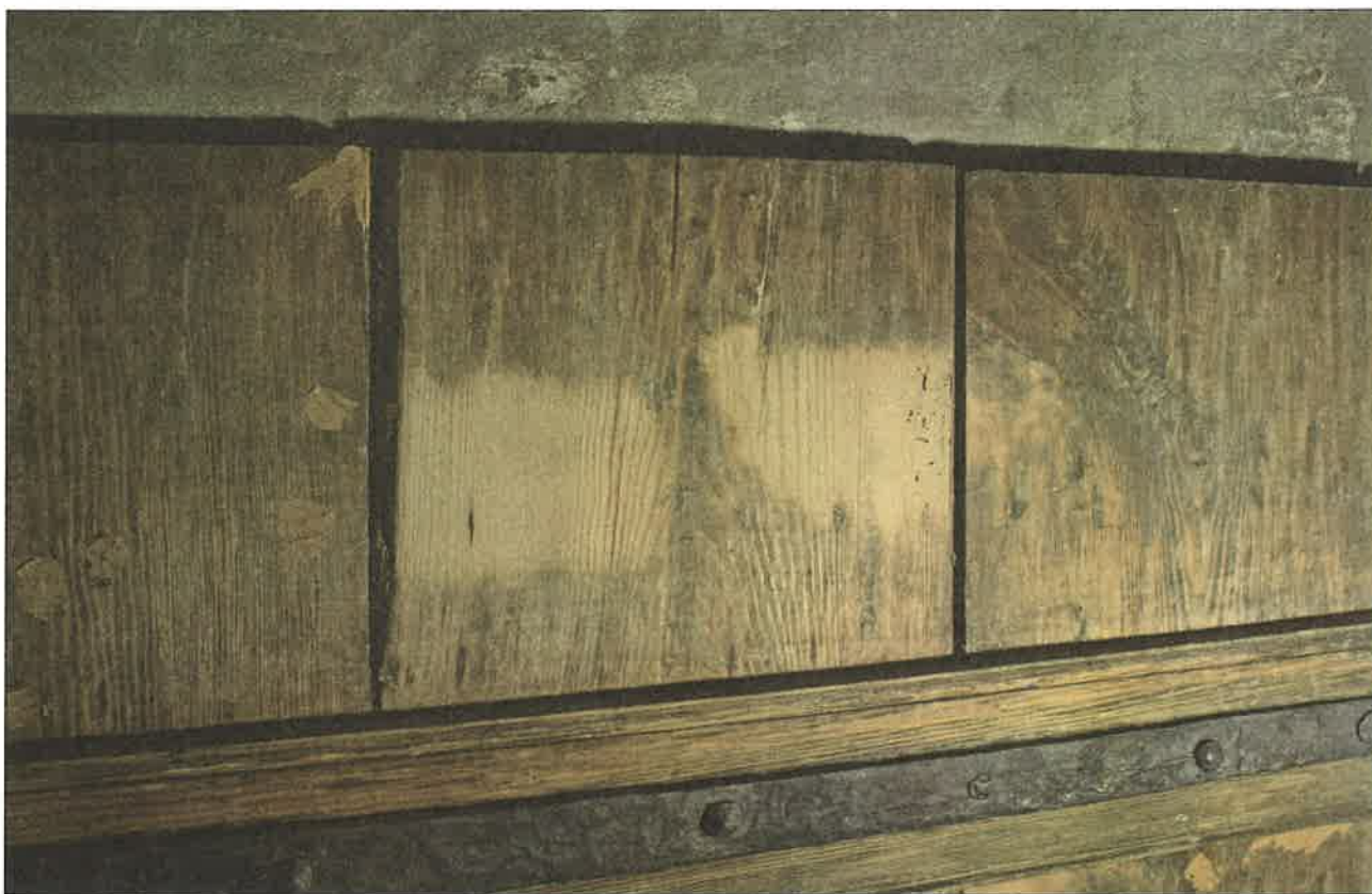
Il. 33. Kościół św. Jakuba w Toruniu. Kruchta północna. Portal zachodni. Sosnowe drzwi w czasie prac konserwatorskich i badań dendrochronologicznych w 2009 r. Fot. A. Konieczny 2009
