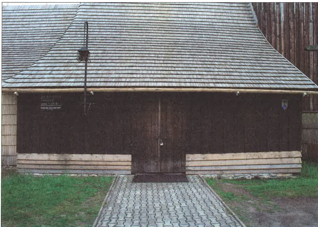
Il. 35. Kościół w Bruśku. Przedsionek północny. Stan po remoncie w 2009 r. Fot. A. Konieczny 2010
