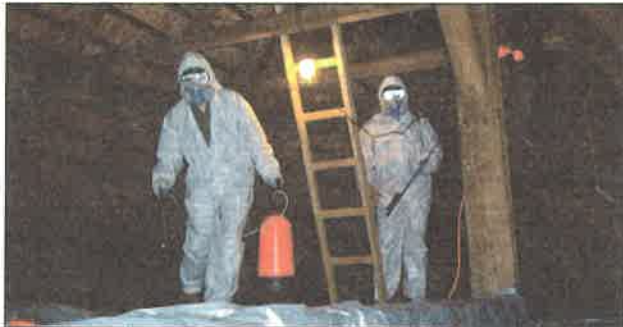
Il. 25. Impregnacja owadobójcza wewnątrz i z zewnątrz obiektów – Muzeum Etnograficzne w Zielonej Górze z siedzibą w Ochli, fot. W. Pszczoliński
