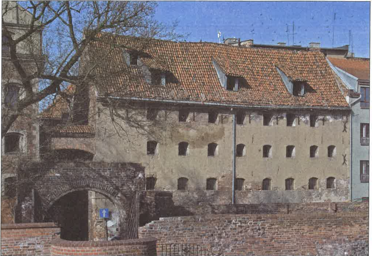
Il. 24. Toruń, spichlerz, ul. Podmurna 13, w widoku od wsch. Stropy nad piwnicą i kondygnacjami I-IV oraz więźba dachowa z 1607 roku. Fot. A. Koniczny 2011
