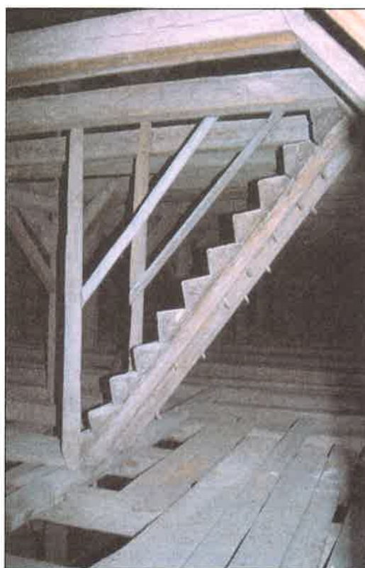
Il. 29. Kolegiata w Dobrym Mieście. Schody z 1395 r. wbudowane w więźbę dachową. Fot. A. Konieczny 2000
