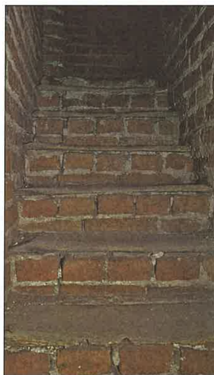
Il. 31. Zamek kapituły warmińskiej w Olsztynie. Drewniane stopnie wmurowane w czasie budowy wieży. Fot. A. Konieczny 2003
