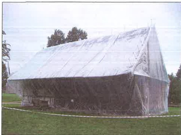
Il. 12. Budynek inwentarski z Kwietniewa, gm. Pasiek w trakcie fumigacji, fot. J. Wiczerzak.
