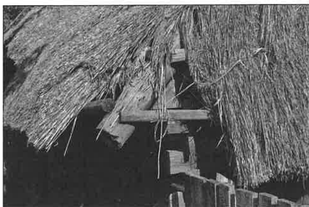
Il. 2. Postępująca degradacja biologiczna więźby dachowej na skutek wyczesania przez wiatr słomy z poszycia dachowego, WPE – Dziekanowice, fot. A. Pelczyk 2008.
