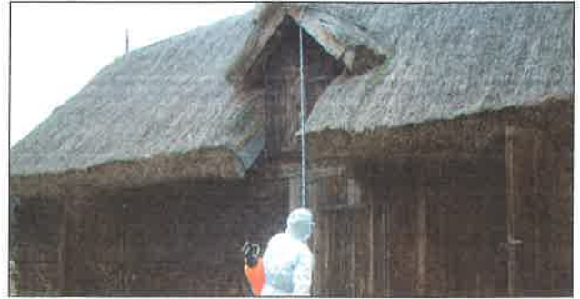
Il. 24. Impregnacja owadobójcza wewnątrz i z zewnątrz obiektów – Muzeum Etnograficzne w Zielonej Górze z siedzibą w Ochli, fot. W. Pszczoliński
