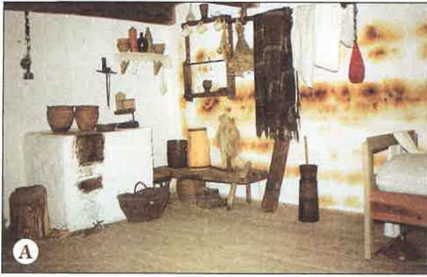
Il. 10. Skutki impregnacji drewna zabytkowego metodą kąpeli w Xylamicie: a) stan po pięciu latach od zabiegu, WPE – Dziekanowice, fot. A. Pelczyk 1987; b) stan po 20 latach od interwencji konserwatorskiej i odizolowaniu zaimpregnowanego drewna od glinianego tynku, WPE – Dziekanowice, fot. A. Pelczyk 2010.
