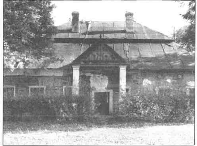
Il. 31. Dwór w Rdzawie, stan przed rozbiórką i translokacją do SPE, fot. A. Cabała, 1969 r.
