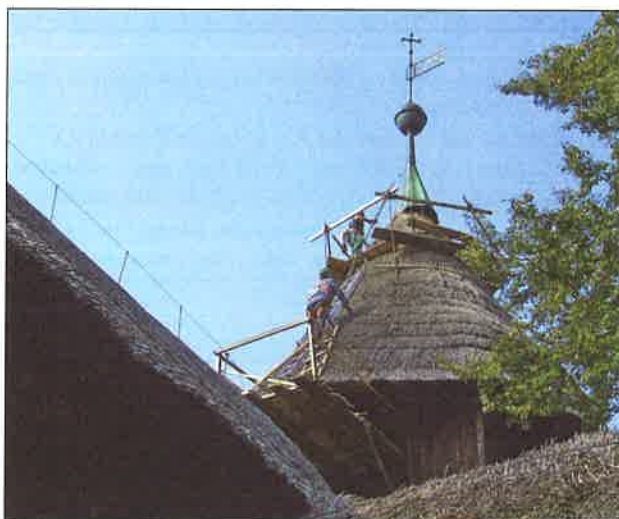
Il. 28. Remont poszycia dachowego wieży kościelnej z Maniek, fot. W. Chodkowska.
