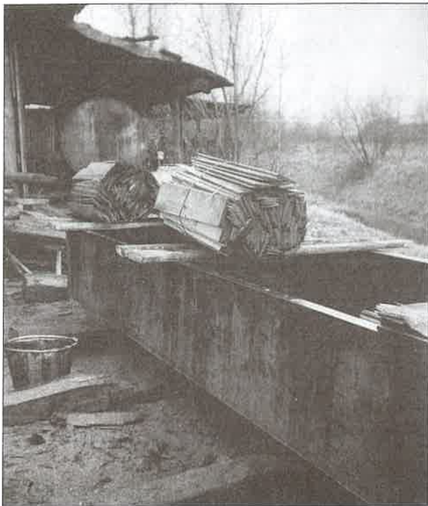
Il. 6. Specjalna wanna ze stali do przeprowadzania, bardzo popularnej w latach 60. i 70. XX wieku, impregnacji drewna poprzez kąpiele w środkach konserwujących, fot. J. Heller 1978.
