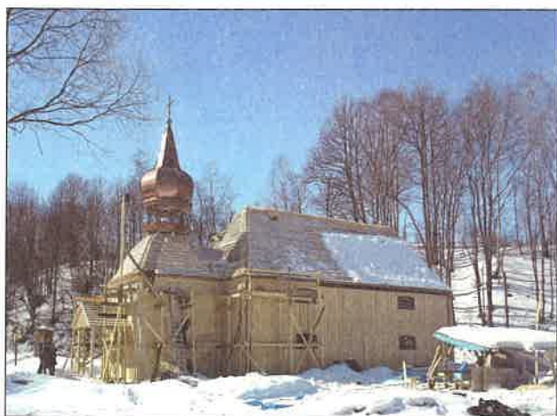
Il. 15. Kościół ze Stadel w trakcie prac rekonstrukcyjnych w SPE, fot. W. Śliwiński 2005 r.
