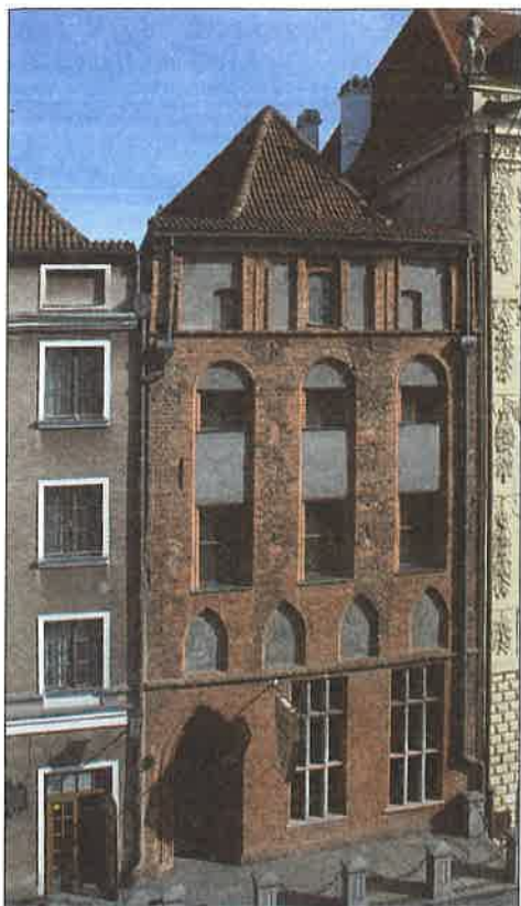
Il. 27. Toruń, kamienica, ul. Żeglarska 10, z najstarszą więźbą dachową nad budynkiem mieszkalnym z 1350 r. Fot. A. Konieczny 2009
