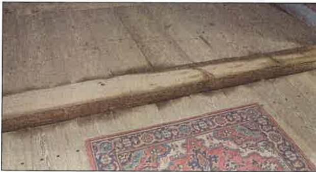
Il. 12. Uboczne skutki impregnacji elementów podłogi (Polska), fot. A. Pelczyk 2010.
