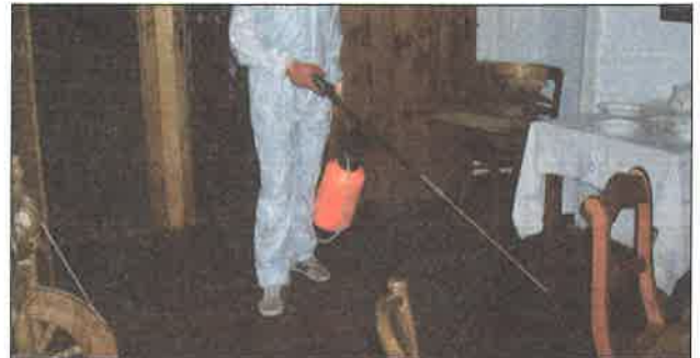
Il. 26. Impregnacja owadobójcza wewnątrz i z zewnątrz obiektów – Muzeum Etnograficzne w Zielonej Górze z siedzibą w Ochli, fot. W. Pszczoliński
