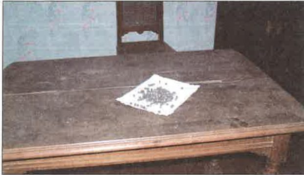
Il. 31. Wyłożenie fosforowodoru – fumigacja, Muzeum Wsi Słowińskiej w Klukach, fot. W. Pszczoliński.
