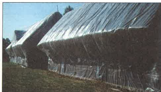
Il. 22. Okrywanie folią i fumigacja obiektów – Muzeum Etnograficzne w Zielonej Górze z siedzibą w Ochli, fot. W. Pszczoliński
