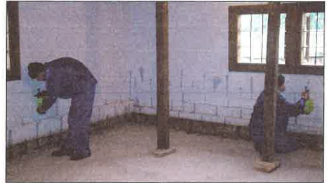
Il. 32. Prace odgrzybieniowe – impregnacja owadobójcza – siatka otworów (Polska), fot. W. Pszczoliński.
