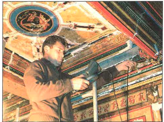
Il. 6. Oględziny przestrzeni wewnątrz stropu w pałacu w Wilanowie – śledzenie zmian położenia sondy na małym monitorze urządzenia.
