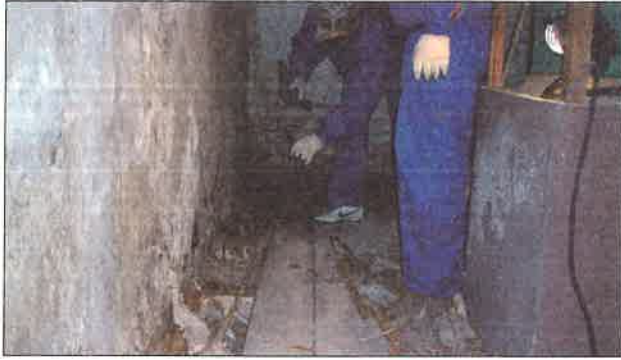
Il. 5. Odkrywka podłogi – widoczna grzybnia grzyba domowego ( Serpula lacrymans ) (Polska), fot. W. Pszczoliński.
