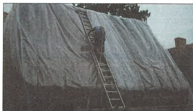
Il. 20. Okrywanie folią i fumigacja obiektów – Muzeum Etnograficzne w Zielonej Górze z siedzibą w Ochli, fot. W. Pszczoliński
