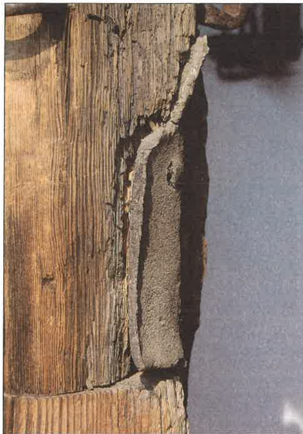
Il. 14. Proces odstawania i kurczenia się płośmy z masy uzupełniającej, WPE – Dziekanowice, fot. A. Pelczyk 2010.
