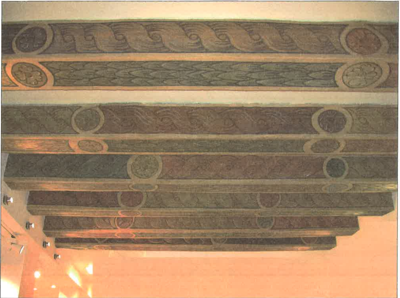
Il. 26. Toruń, kamienica, ul. Szeroka 19. Malowany strop belkowy z 1364 r. Kompleksowe badania dendrochronologiczne konstrukcji drewnianych kamienicy przeprowadzone w 2008 r. Fot. A. Konieczny 2010
