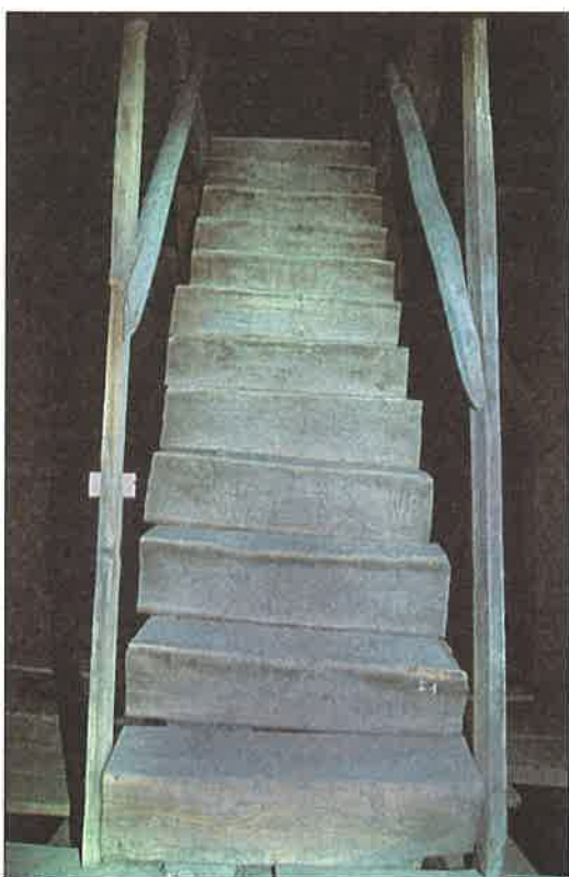
Il. 29. Kolegiata w Dobrym Mieście. Schody z 1395 r. wbudowane w więźbę dachową. Fot. A. Konieczny 2000
