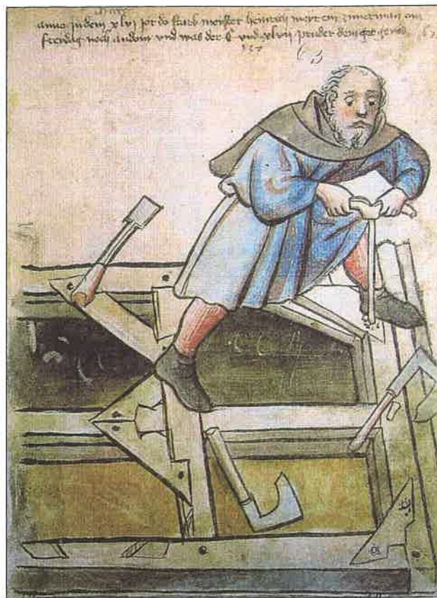
Il. 2. Ciesla skręcający konstrukcję drewniane więźby dachowej (za: D. Mącznyński, w: Renowacje. Zabytki 3(35)2010, s. 150)
