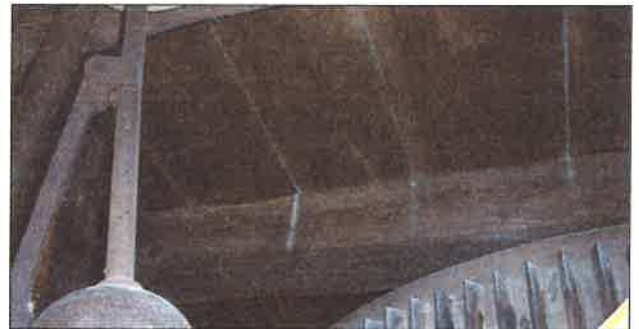
Il. 8. Ślady porażenia przez spuszczela pospolitego ( Hylotrupes bajulus ), Muzeum Kultury Ludowej w Osieku nad Notecią, fot. W. Pszczoliński.
