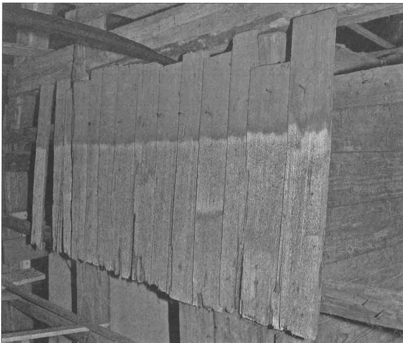
Il. 15. Kościół w Łaziskach. Dawna połać zachodnia dachu nawy – szczyt zachodni (osłonięta dobudowaną w 1507 r. wieżą). Oryginalny gont z czasu budowy kościoła w 1467 r. Fot. A. Konieczny 2008
