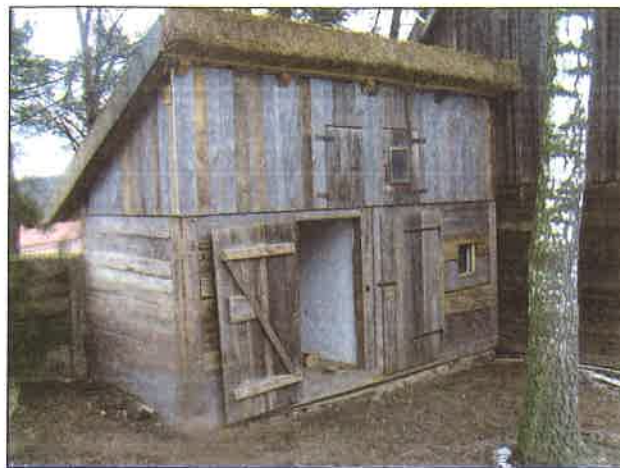
Il. 21. Kurnik z Jerutek. Budynek po konserwacji, fot. M. Poniewski.
