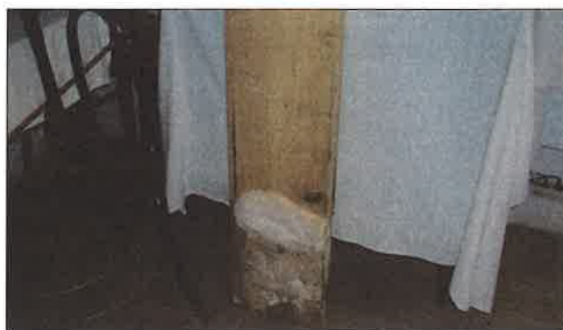
Il. 2. Odkrywka deski podłogowej - młoda grzybnia grzyba domowego ( Serpula lacrymans ) (Polska), fot. W. Pszczoliński.
