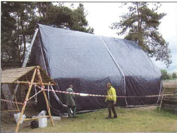
Il. 19. Fumigacja budynku gospodarczego z Jerutek gazem eutralnym, fot. A. Kuberka.
