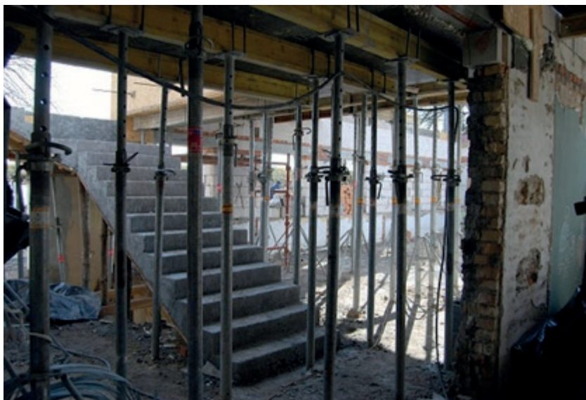
Ryc. 72. Budowa klatki schodowej w budynku głównym Muzeum
