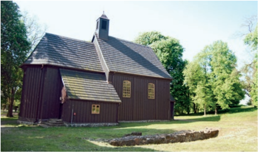
Ryc. 16. Drewniany kościół pw. św. Jana Chrzciciela — widok od północnego wschodu stan z 2013 r.) z widocznym fragmentem reliktyw fundamentów średniowiecznego kościoła Jana Chrzciciela
