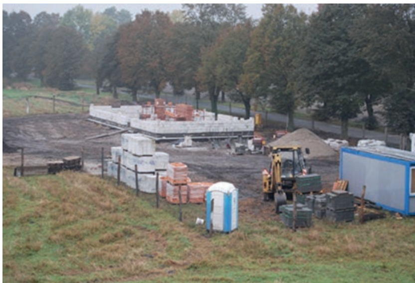
Ryc. 70. Budowa budynku wystaw czasowych na osadzie edukacyjnej (październik 2009)
