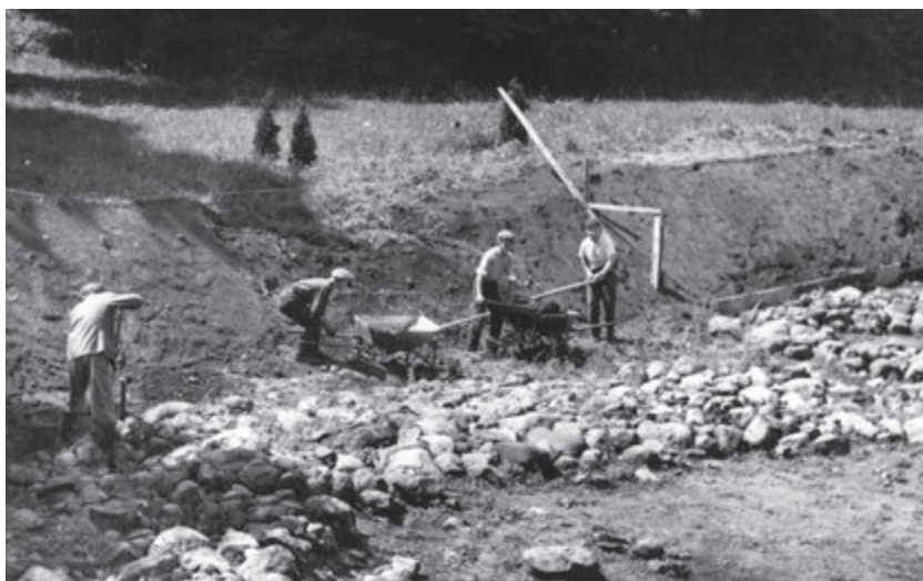
Ryc. 56. Prace porządkowe przygotowujące fundamenty palatium do ekspozycji in situ (czerwiec 1963)
