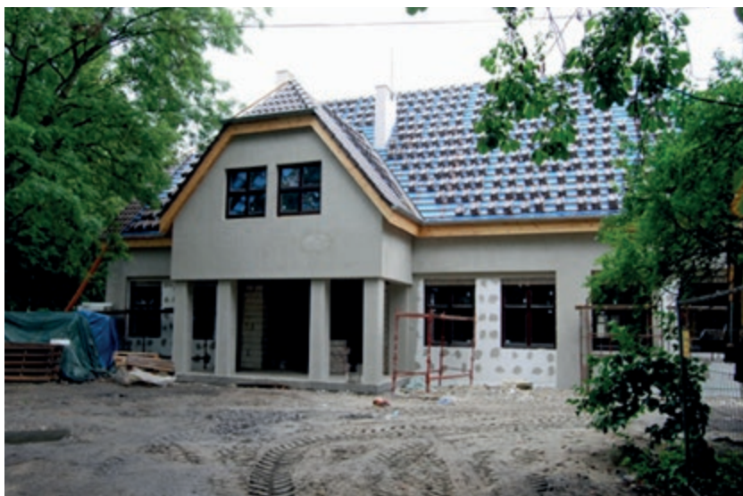
Ryc. 71. Budowa głównego budynku Muzeum (sierpień 2010)
