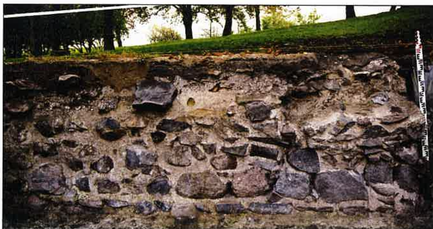
Ryc. 22. Giecz-Grodziszczko, stan. 1. Lico ściany wschodniej wolnostojącej budowli odsłoniętej na zachód od kościoła grodowego (fot. T. Krysztofiak; październik 2002) Fig. 22. Giecz-Grodziszczko, site 1. The facing of the eastern wall of the detached building uncovered to the west of the stronghold church (photograph by T. Krysztofiak; October 2002)
