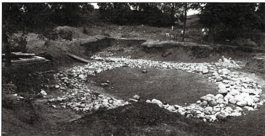
Ryc. 3. Giecz-Grodziszczko, stan. 1. Fundamenty palatium w Gieczu podczas badań 1953 (fot. Archiwum MAP) Fig. 3. Giecz-Grodziszczko, site 1. Foundations of the palatium in Giecz during research 1953 (photograph – Archive of PAM)
