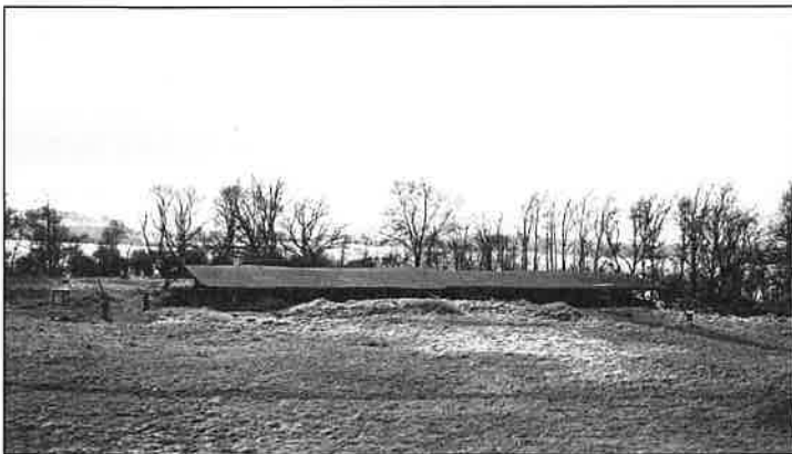
Ryc. 16. Ostrów Lednicki – drewniane zadaszenie nad ruinami z pomostami umożliwiającymi wejście do wnętrza historycznej budowli (fot. Archiwum MPP) Fig. 16. Ostrów Lednicki (Lednica Holm) – a wooden shed over the ruins with catwalks making access to the interior of the historic building possible (photograph – Archive of MFPL)
