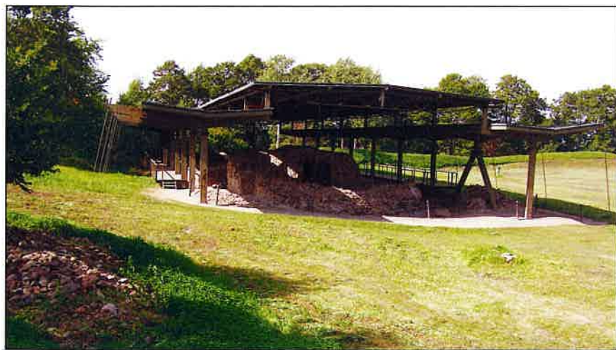
Ryc. 58. Ostrów Lednicki – zadaszenie nad ruinami postawione w 1978 roku i ochraniające budowlę przez niemal 30 lat (fot. W. Kujawa; 2004)
