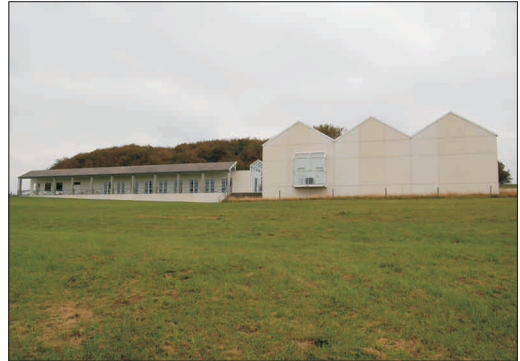
Fot. 12b. Lindholm Høje Musset. Budynek muzealny - tył (fot. A. Pelczyk) Lindholm Høje Musset. Building in the Vikings museum in Ålborg - the rear (photograph by A. Pelczyk)
